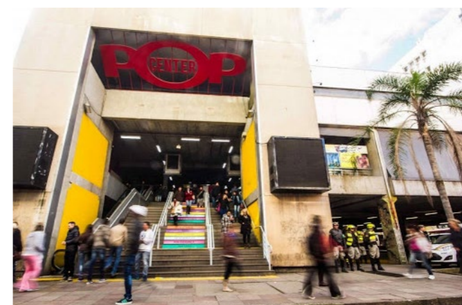
Figura 30 - Fachada Principal do PoP Center
