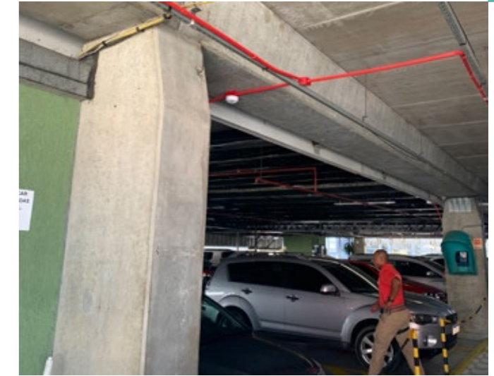
Encontro estrutura concreto pré-fabricado e estrutura metálica adicionada posteriormente
