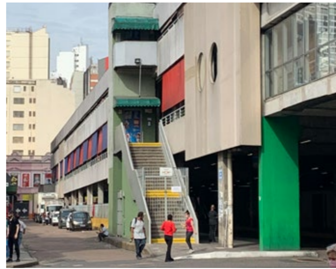
Estacionamento lateral, acessos e gradis metálicos anexados para controle e segurança
