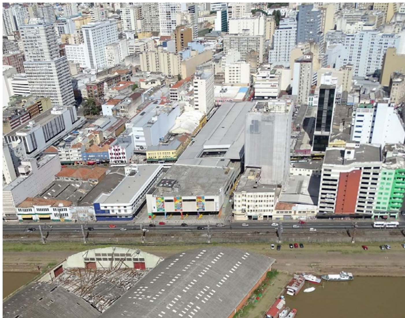
Figura 27 - Vista aérea Fachada Norte do Centro Popuar de Compras de Porto Alegre / 2019
