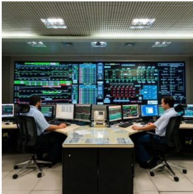
Figura 6: Sala de controle central da usina hidrelétrica Itaipu Binacional. Fonte: (CBIE, 2019)
