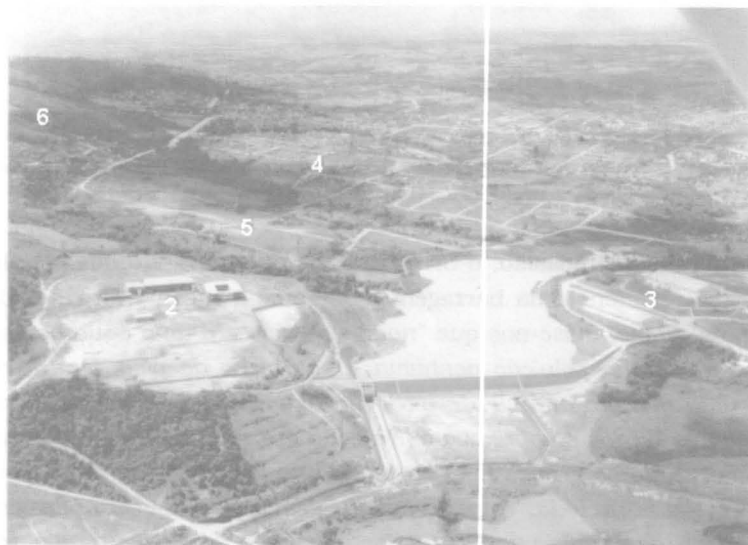
Foto 3 – Situação após a construção da barragem Mãe d’Água e preenchimento do lago, no dia 25 de setembro de 1963: (1) barragem Mãe d’Água; (2) Campus Vale; (3) Instituto de Pesquisas Hidráulicas; (4) Loteamento Santa Isabel; (5) Loteamento Jardim Universitário; (6) Morro Santana
