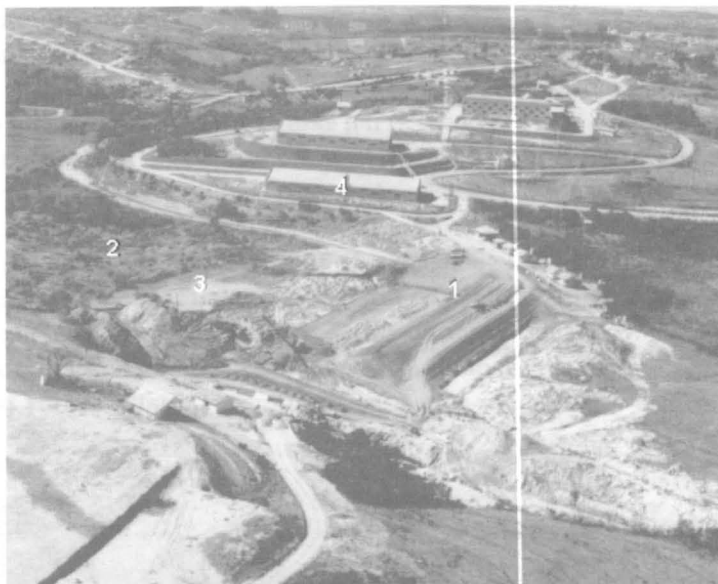
Foto 2 – Situação durante a construção da barragem Mãe d’Água no dia 18 de agosto de 1961: (1) Obras para a construção da barragem Mãe d’Água; (2) Mata Ciliar (eliminada) do arroio Mãe d’Água; (3) Pequena bacia de acumulação; (4) Instituto de Pesquisas Hidráulicas
