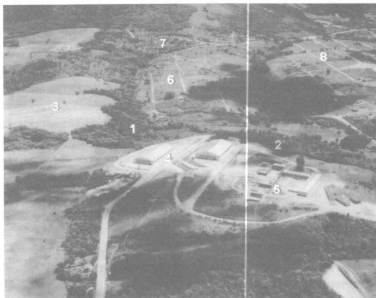
Foto 1 – Situação anterior à construção da barragem Mãe d'Água (provavelmente em 1960): (1) Mata Ciliar; (2) Arroio Mãe d'Água; (3) Futuro local do Campus Vale; (4) Instituto de Pesquisas Hidráulicas; (5) Prédios em construção do Instituto de Pesquisas Hidráulicas; (6) Loteamento Jardim Universitário; (7) Loteamento Nossa Senhora Aparecida; (8) Loteamento Santa Isabel
