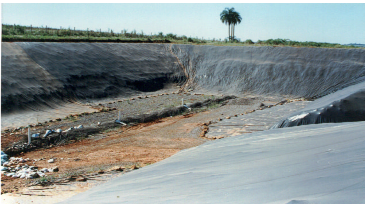
Figura 06: Vista da vala de lixo do Aterro Sanitário em construção - 1996
