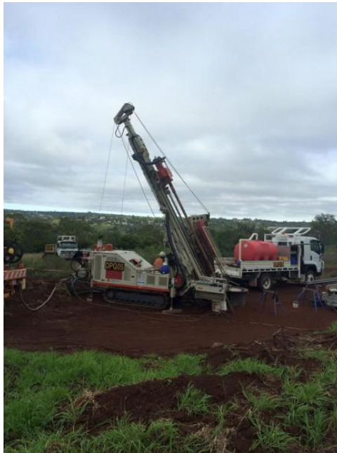
Figura 28 Figura representativa de campanha de sondagem rotativa
