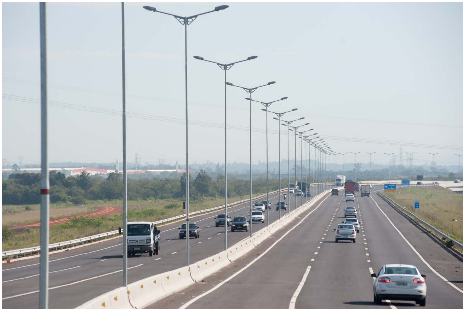
Inaugurada em dezembro, a nova rodovia atravessa uma região caracterizada por banhados de profundidades variáveis, o que exigiu complexas soluções de engenharia
