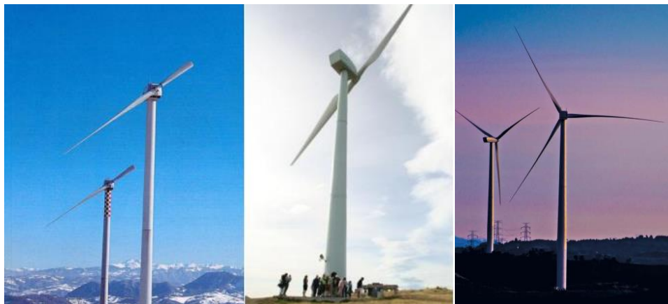
Figura 2.13 – HAWT de 1, 2 e 3 pás (OLIVEIRA, 2012; GWEC, 2018).
