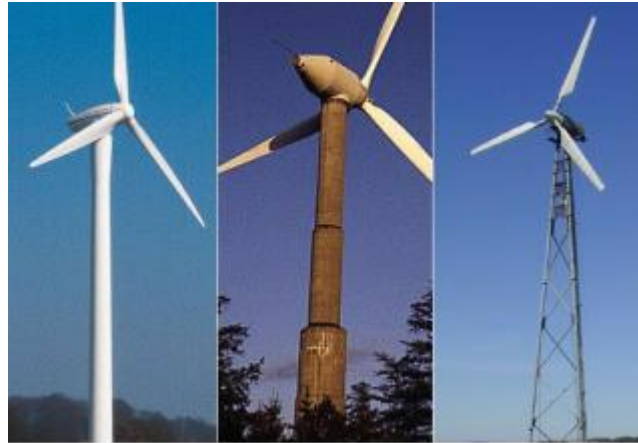
Figura 2.15 – Aerogeradores com torre tubular de aço, tubular de concreto e treliçada (GUIDELINES..., 2002).
