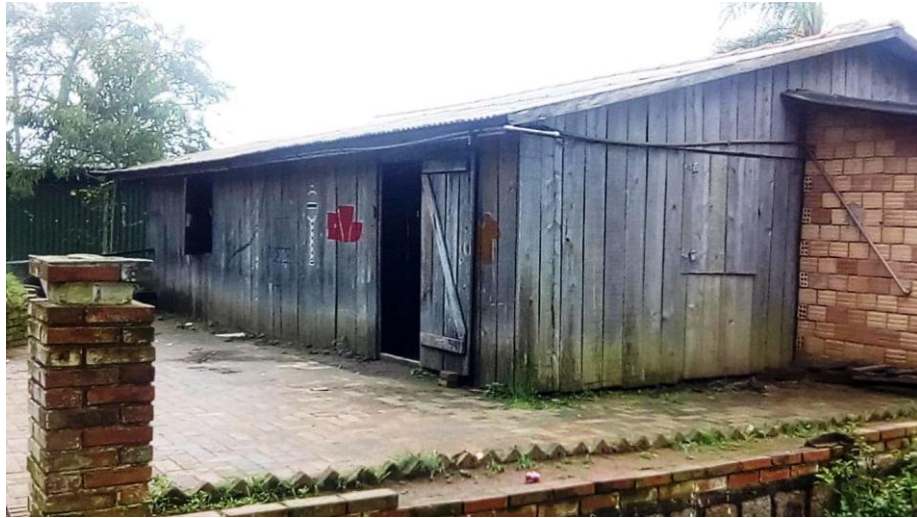
Figura 4 - Prédio da escola
