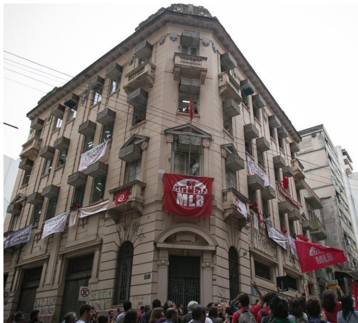
Figura 16 – Prédio da Ocupação Lanceiros Negros
