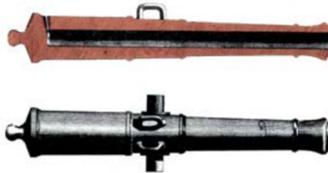
Figura 8 – Canhão fabricado pelo processo Jean Maritz
