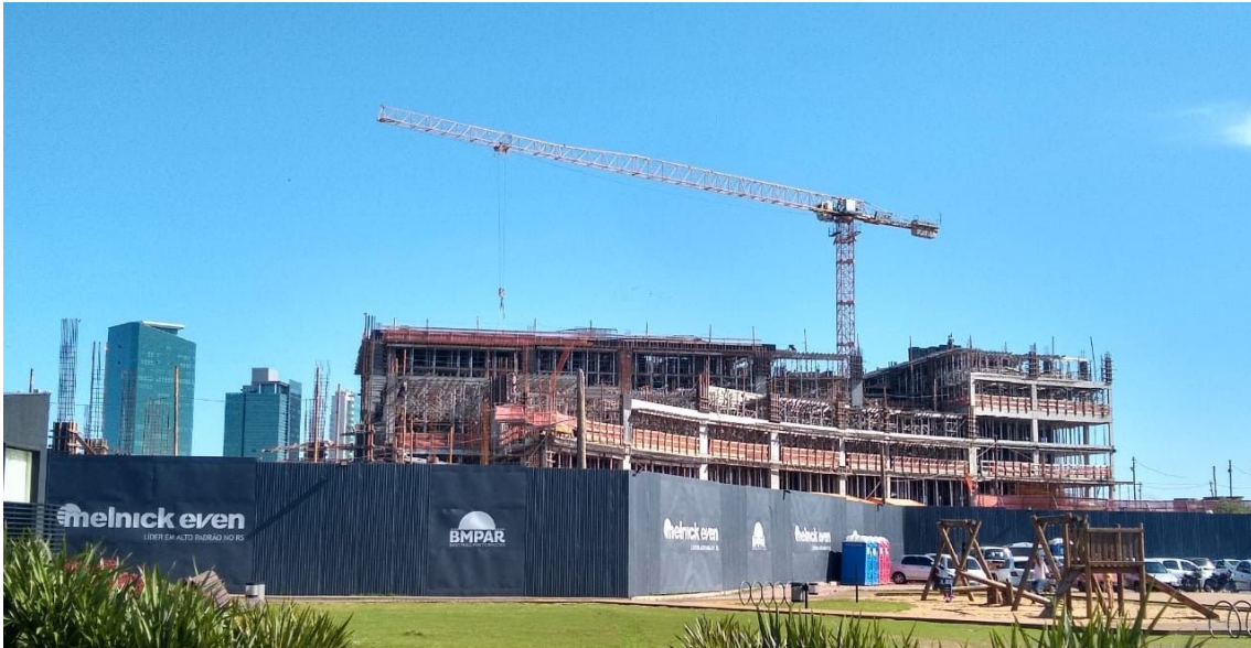
Figura 24. Empreendimento em construção. Foto de novembro de 2019. Foto: Manoela Rodrigues
