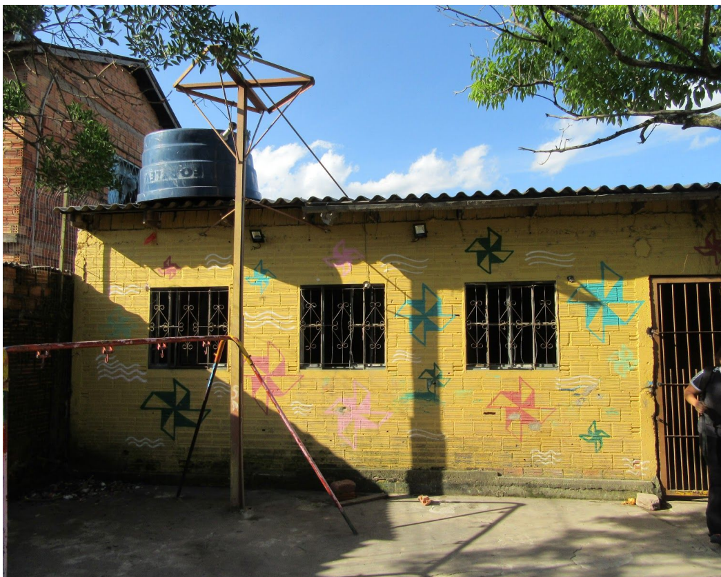
Figura 2 - Foto feita no pátio da Casa dos Cata-Ventos. Vista da fachada.
