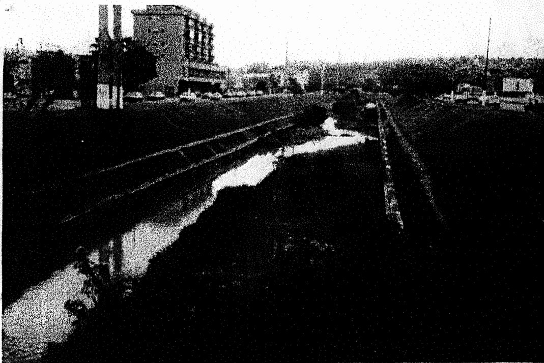
Figura V.2 - Arroio Dilúvio, nas proximidades da seção 8
