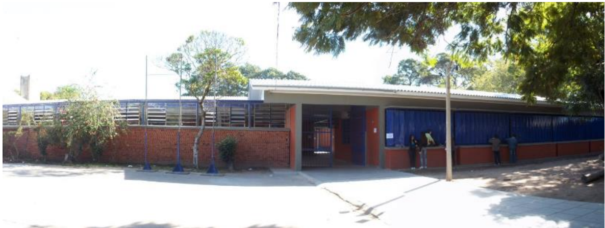
Figura 3.1: Entrada principal do prédio de salas de aula.
