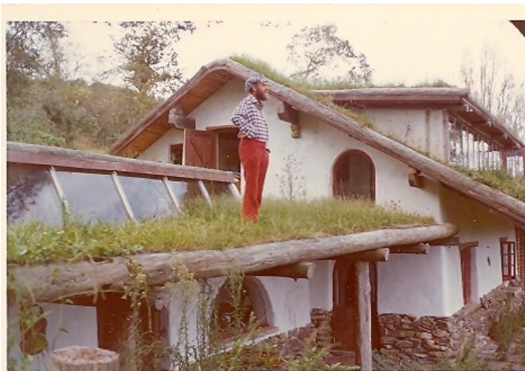
Figura 8 - Hundertwasser na casa com telhado de grama construída por Ivan Tarulevic na Baía da abundância. 1975
