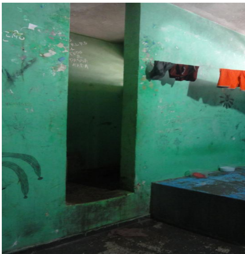
Foto 4 – Alojamento Masculino da Unidade 1 Porta de acesso ao banheiro
