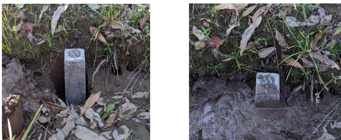
Figura 20 - Processo de instalação do marco geodésico Fonte: as autoras
