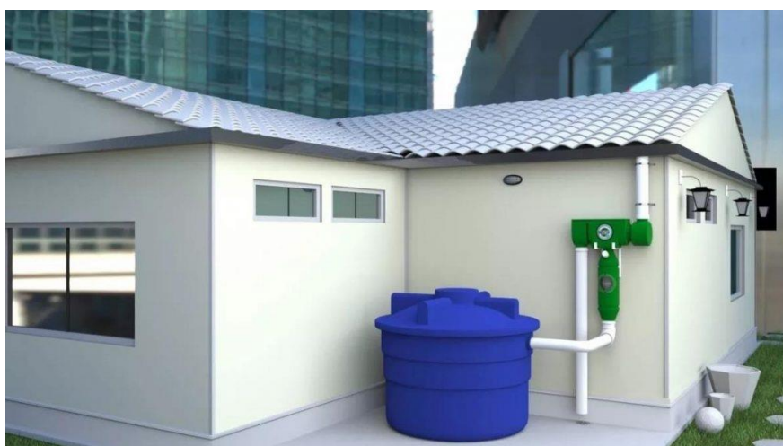
Figura 11 - Reservatório no nível do solo
