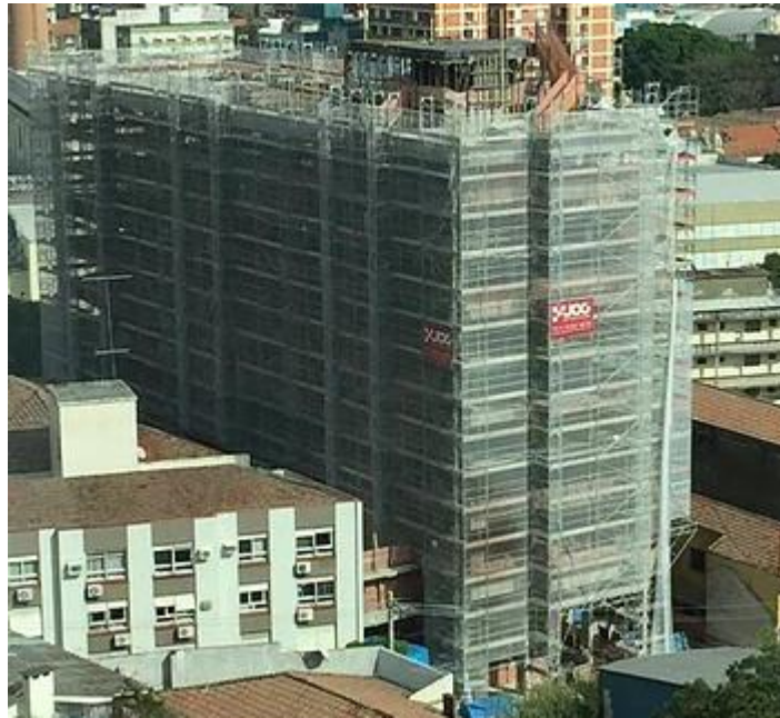
Figura 1 – Construção utilizando andaime fachadeiro do tipo modular
