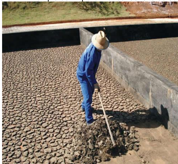
Figura 9.4 – Exemplo de limpeza manual do leito de secagem
