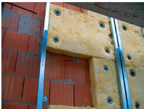
Figura 30: Mantas de lã de rocha utilizadas como isolante térmico.
