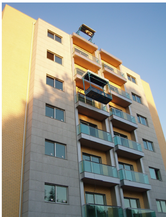
Figura 35: Balancim elétrico para equipe de produção.
