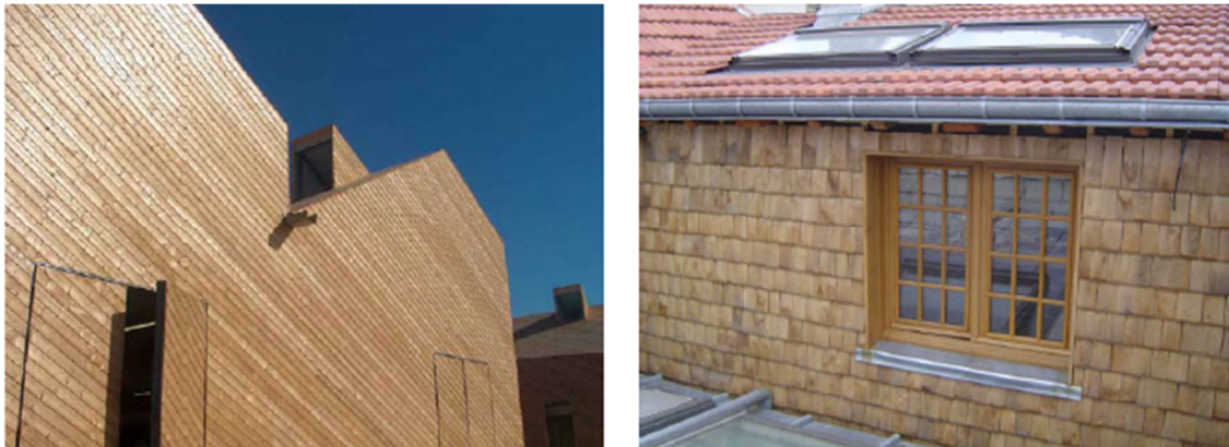
Figura 10: Fachada ventilada com revestimento em madeira.
