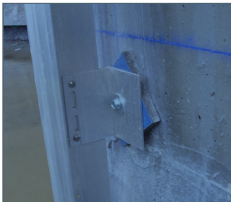
Figura 37: Utilização de calços na fixação de ancoragens.
