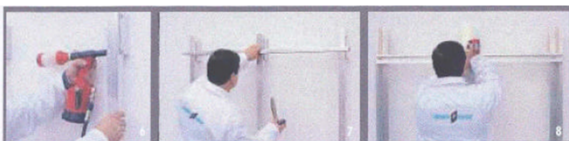
Figura 39: Fixação dos perfis.
