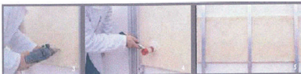
Figura 38: Instalação do isolante térmico.
