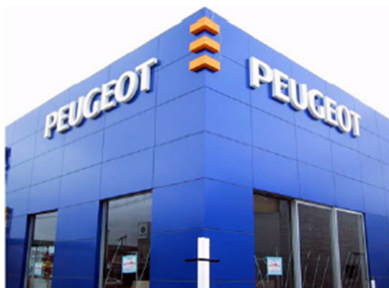
Figura 12: Edificação como fachada de ACM.
