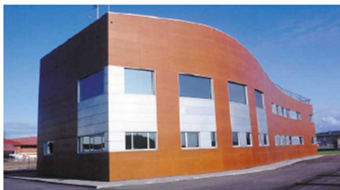
Figura 9: Sistema executado com painéis fenólicos.
