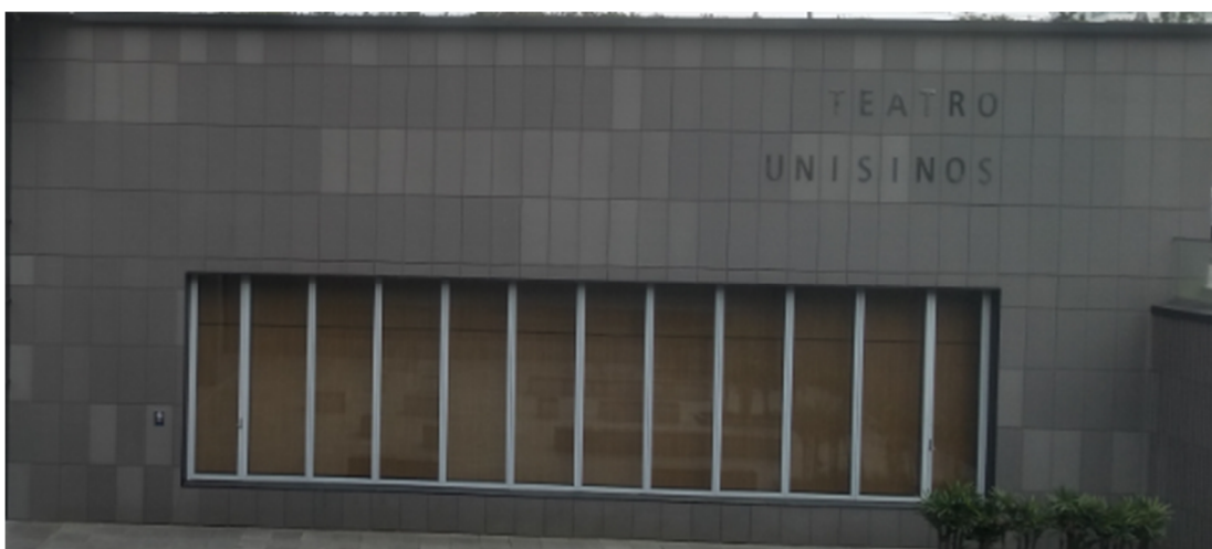
Figura 50: Imagem do local terminado
