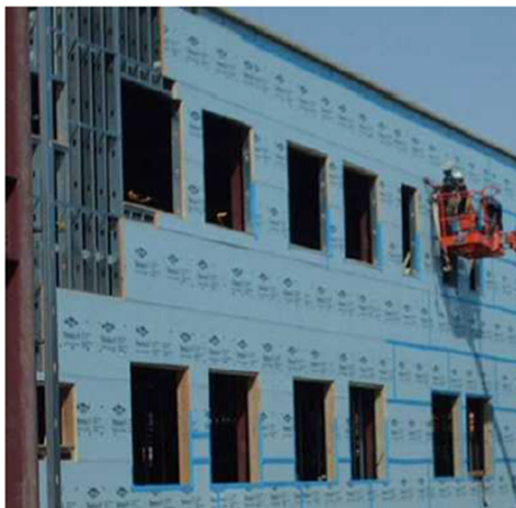
Figura 29: Execução de isolante térmico de XPS.
