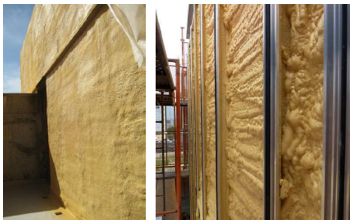
Figura 31: Espuma de poliuretano projetado.
