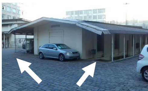
Figura 105 – Prédio de funcionários da manutenção
