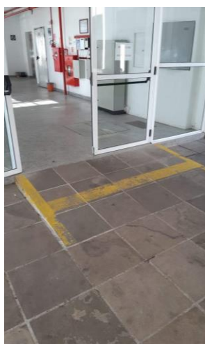
Figura 118 – Rampa na porta de entrada do prédio de Salas de Aula
