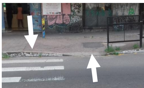
Figura 49 – Guia rebaixada
