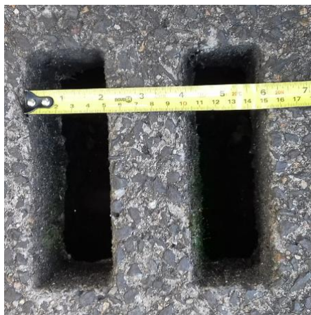
Figura 112 – Detalhe vãos da grelha
