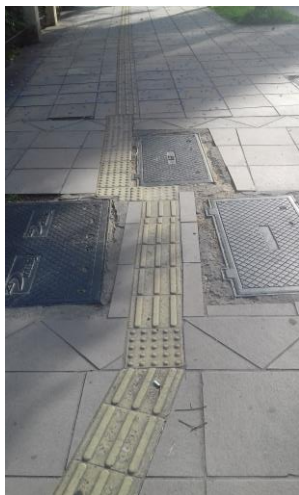
Figura 85 - Piso tátil contornando tampas de caixa de inspeção
