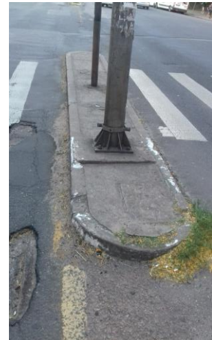
Figura 95 – Detalhe canteiro Avenida João Pessoa
