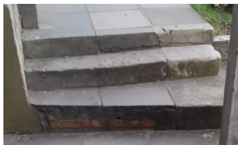
Figura 26 - Escada ao final do trecho
