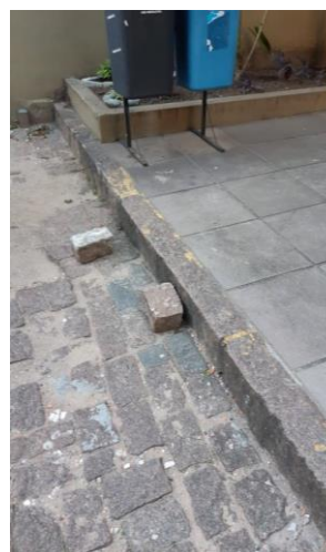
Figura 28 – Detalhe degrau entre a Escola de Engenharia Nova e o Instituto Eletrotécnico
