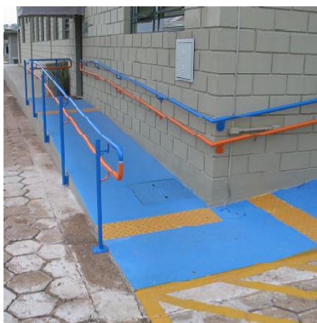
Figura 123 – Exemplo de rampa acessível
