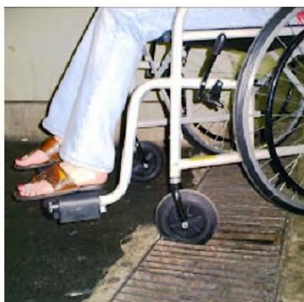
Figura 74 – Exemplo de situação em que a distância entre os vãos não é respeitada
