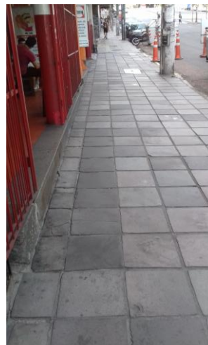
Figura 55 - Calçada Avenida João Pessoa
