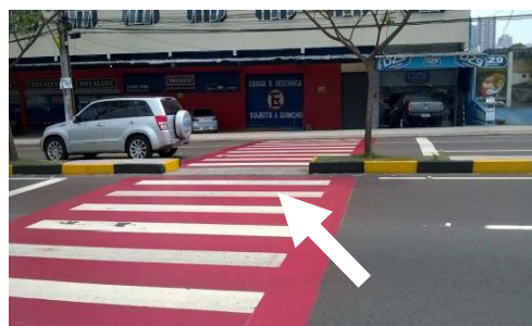
Figura 98 – Exemplo de via com canteiro central rebaixado
