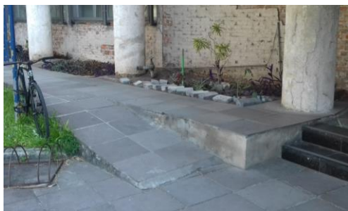
Figura 25 - Rampa em direção ao Instituto Eletrotécnico
