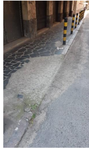
Figura 51 - Rebaixo de guia na Rua Avai
