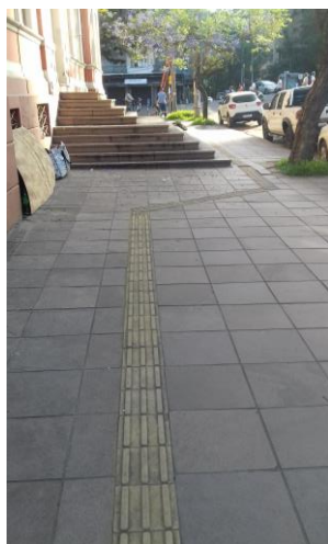
Figura 87 - Desvio das escadarias da entrada do prédio Centenário da Escola de Engenharia
