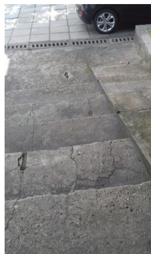
Figura 111 - Veículo diminuindo o espaço de acesso a rampa
