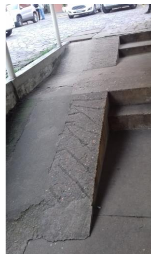
Figura 107 - Rampas de acesso prédio de manutenção dos terceirizados
