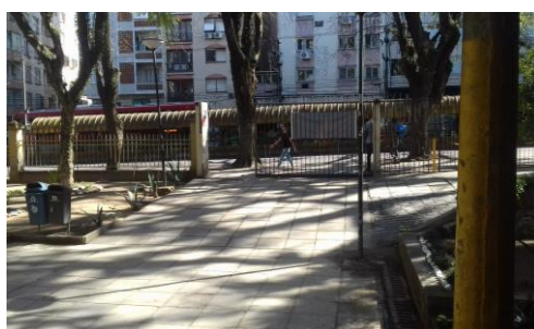
Figura 40 – Rampa de acesso ao portão da Avenida João Pessoa
