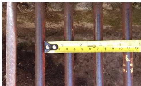
Figura 73 – Detalhe espaçamento dos vãos
