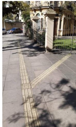
Figura 86 - Portão desativado por questões de segurança
