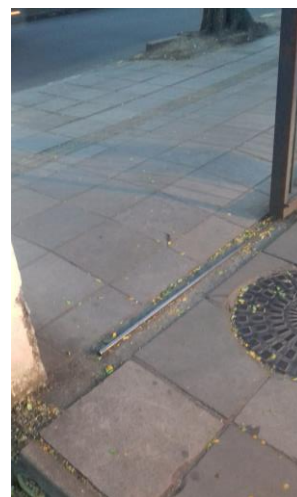
Figura 43 – Piso tátil sem ligação com o portão
