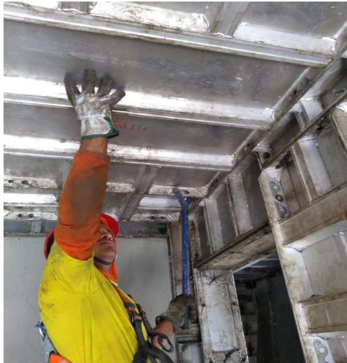
Figura 19: Montador realizando a desforma
