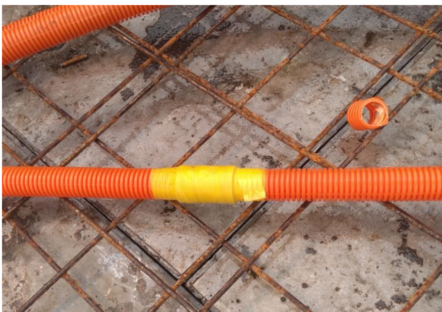
Figura 108: Conduíte após conserto
