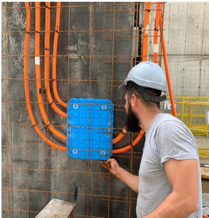
Figura 127: Instalação dos pontos elétricos do hall
