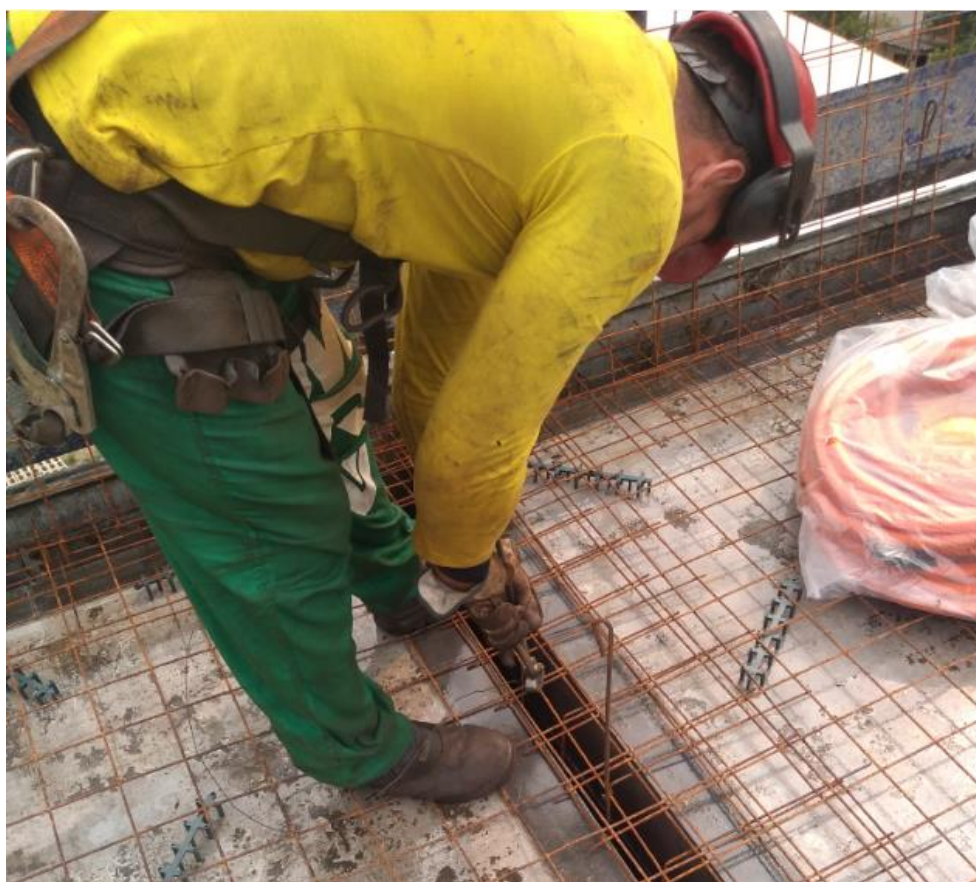
Figura 100: Fixação das telas
