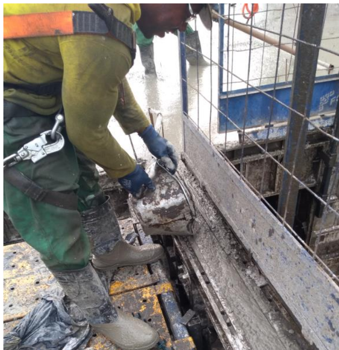
Figura 112: Montador utilizando balde para preencher as paredes com concreto
