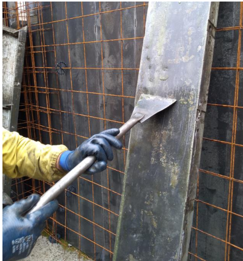
Figura 72: Montador raspando nata de concreto do painel
