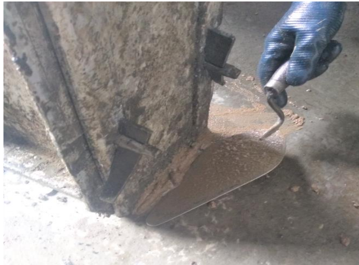
Figura 76: Montador fechando as frestas com massa magra
