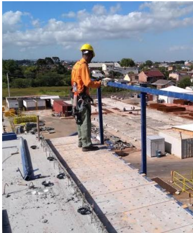
Figura 85: Montador montando as longarinas superiores
