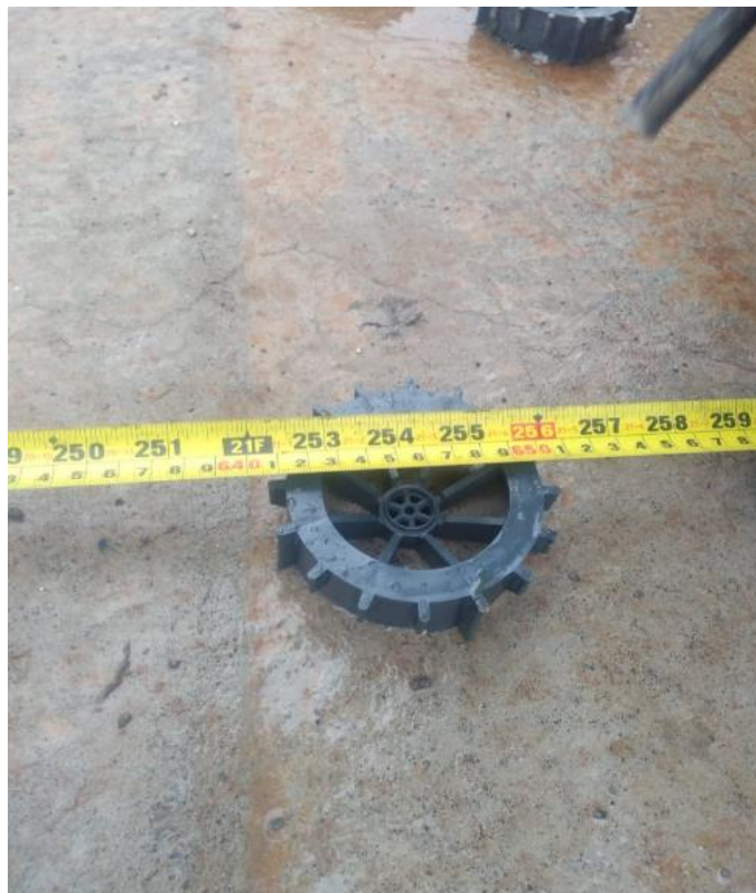
Figura 45: Espaçadores posicionados no centro das linhas de espessura
