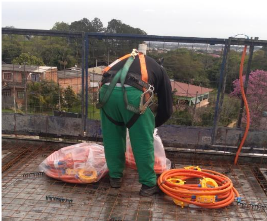
Figura 104: Kit's elétricos separados por cômodos
