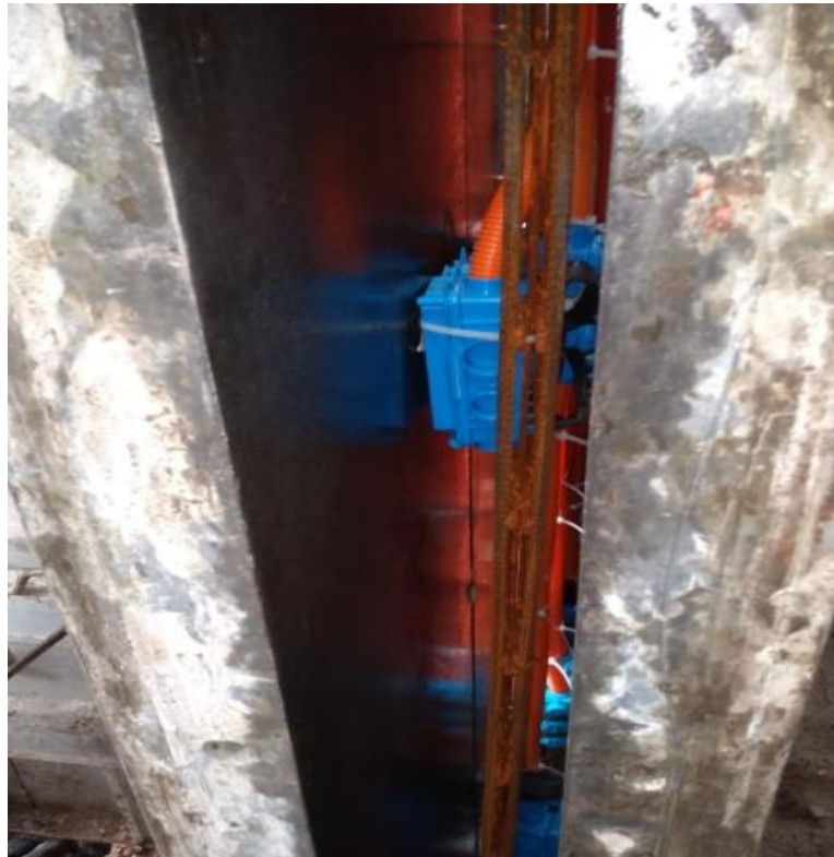
Figura 129: Caixas elétricas faceadas às formas da parede
