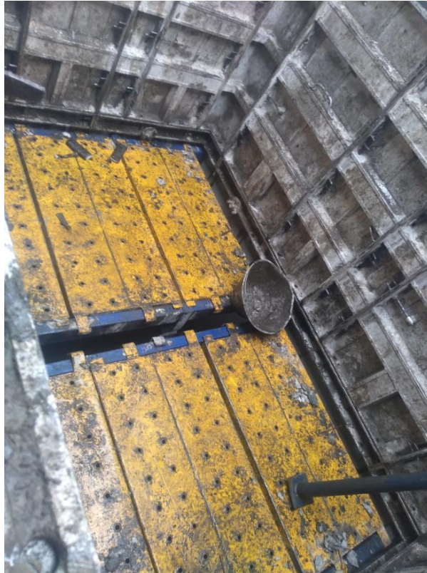
Figura 58: Plataforma de pós concretagem
