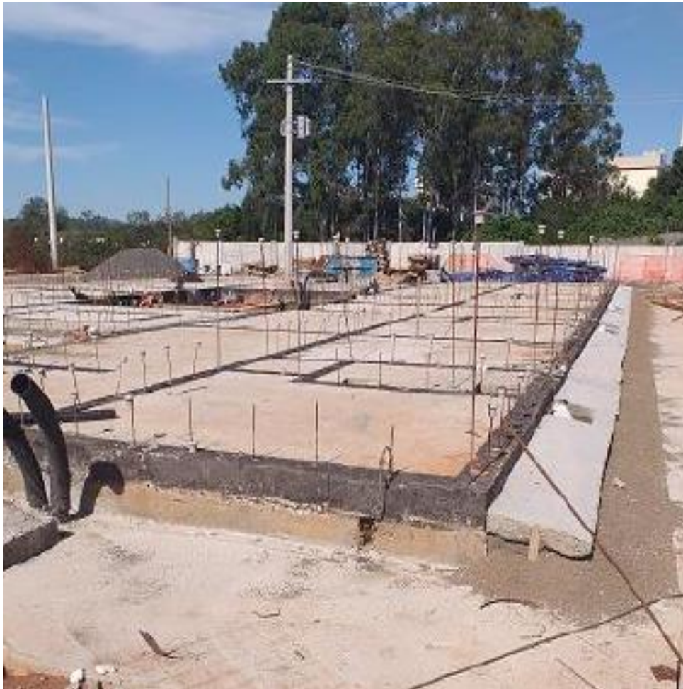
Figura 3: Fundação do tipo radier
