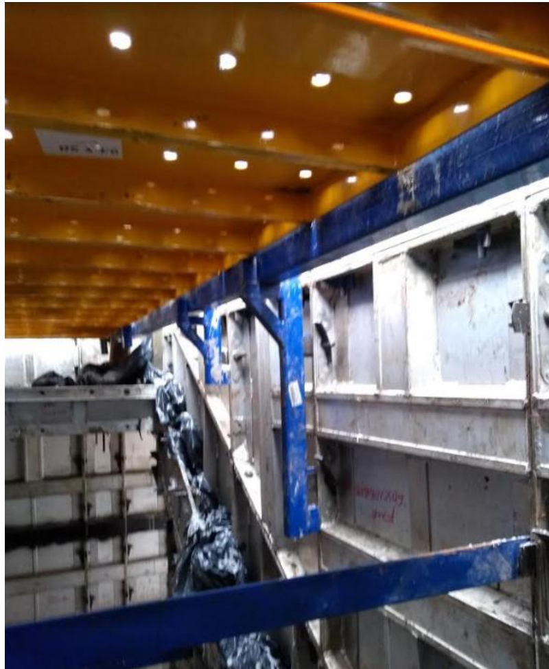
Figura 59: Plataforma de pré concretagem
