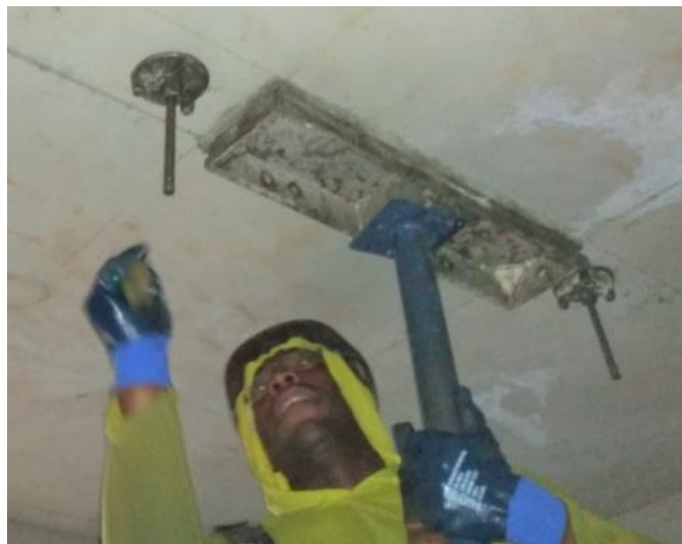
Figura 89: Montador fixando as agulhas
