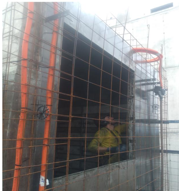
Figura 67: Parede interna da fachada montada
