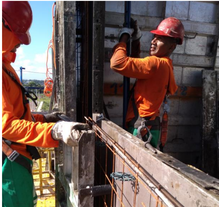
Figura 12: Montagem dos painéis internos e externos simultaneamente
