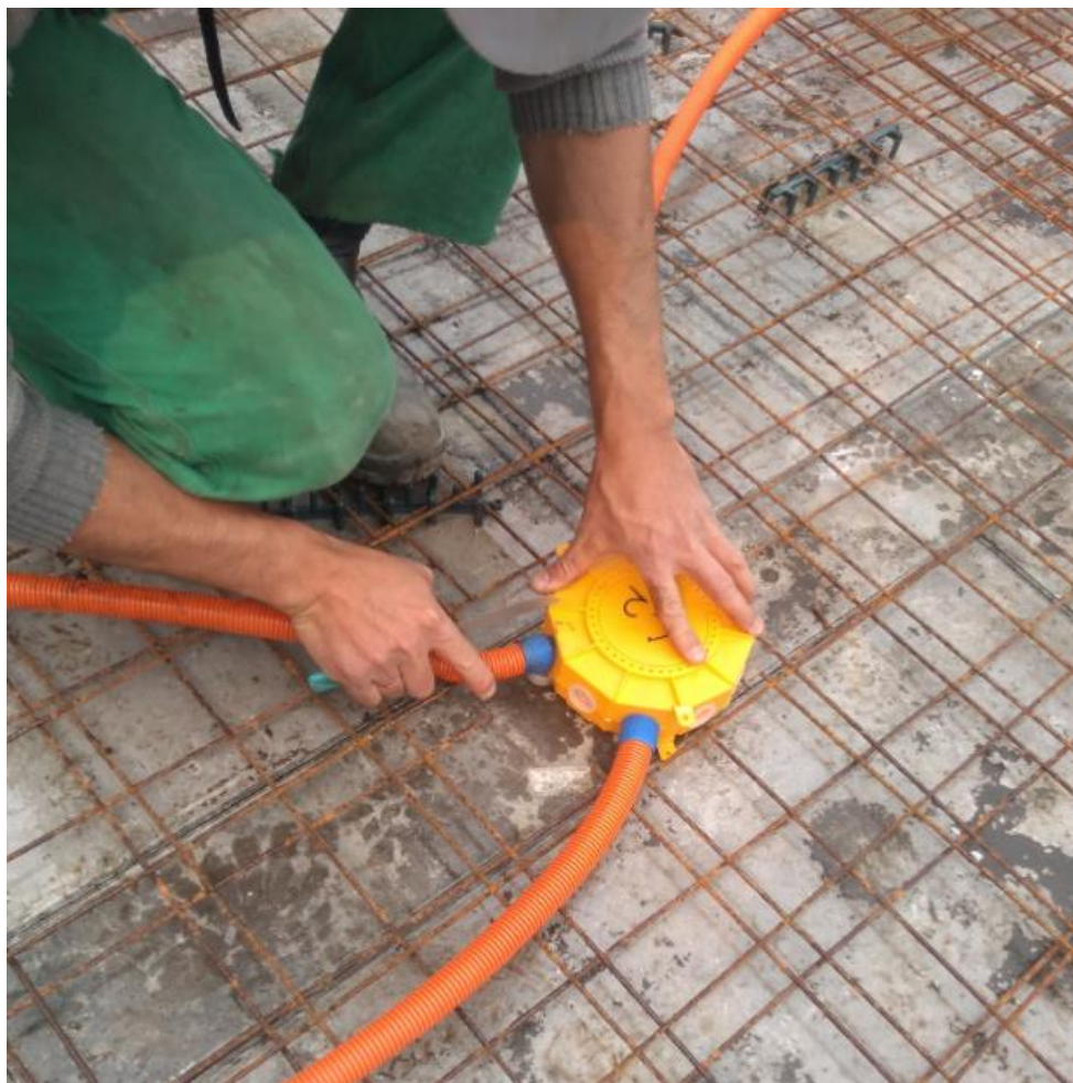
Figura 106: Fixação das mangueiras elétricas
