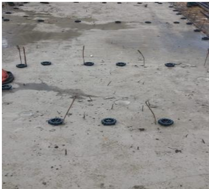
Figura 47: Espaçadores distanciados
