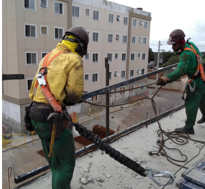
Figura 55: Montadores desmontando as longarinas superiores
