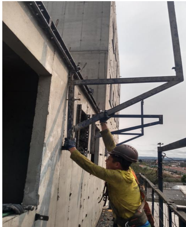
Figura 79: Montador instalando as mãos francesas
