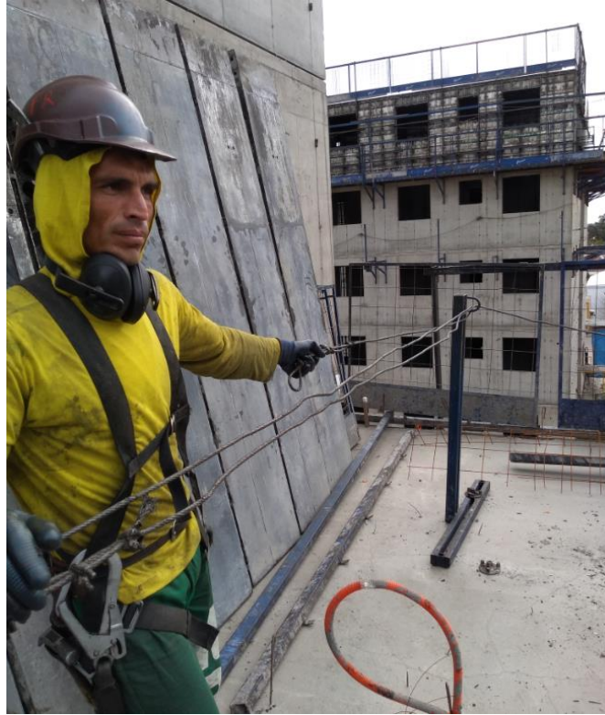
Figura 51: Montador passando o cabo pelo anel de suporte do “T”
