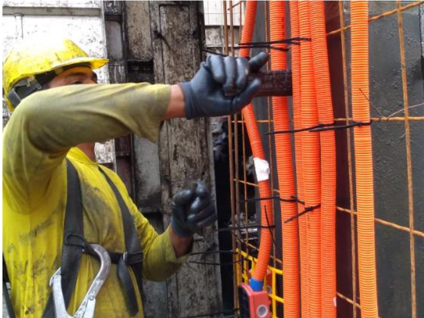
Figura 71: Montador colocando camisinha na faqueta
