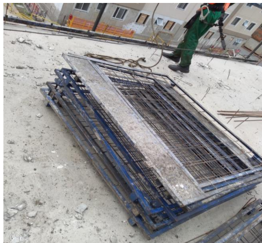
Figura 54: Guarda-corpos armazenados na laje
