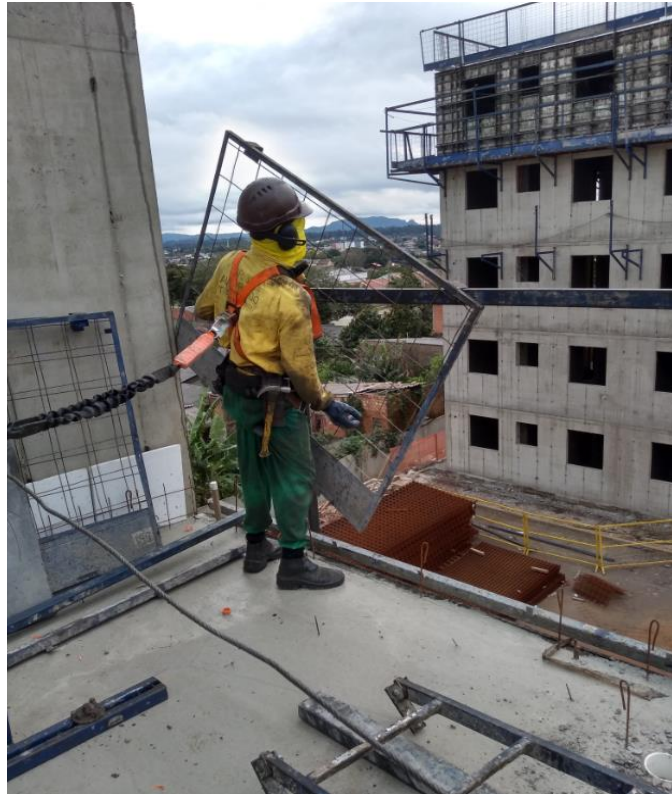
Figura 53: Montador desmontando as peças do guarda-corpo
