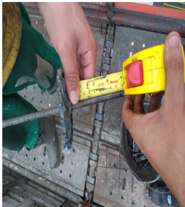
Figura 115: Medidor de nível da laje
