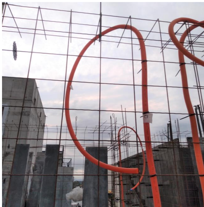
Figura 128: Mangueiras elétricas encaixadas no alto da armação
