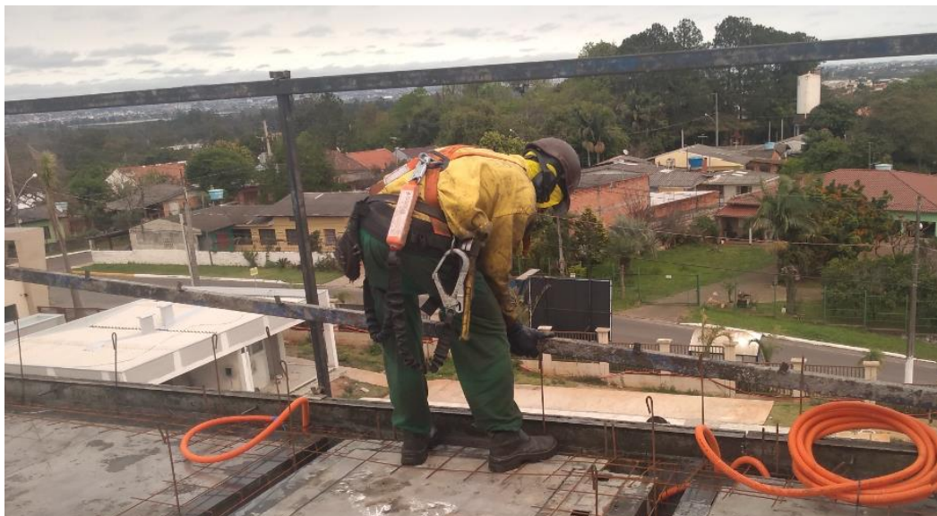
Figura 94: Montagem da longarina inferior
