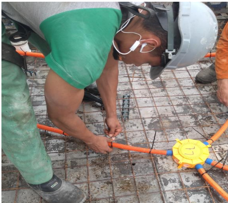
Figura 107: Fixação das mangueiras elétricas com abraçadeiras de nylon
