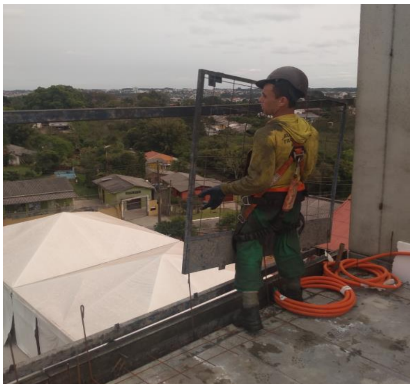
Figura 95: Montador encaixando os guarda-corpos
