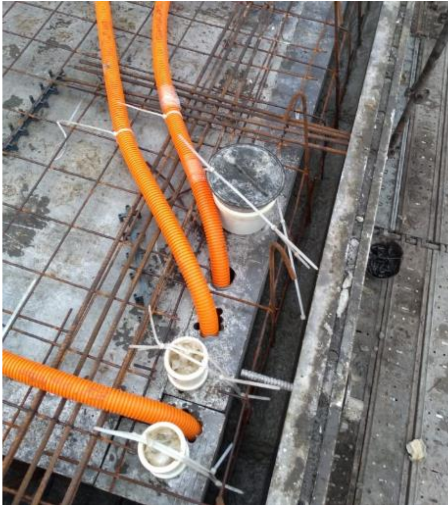
Figura 101: Reforços na abertura do shaft
