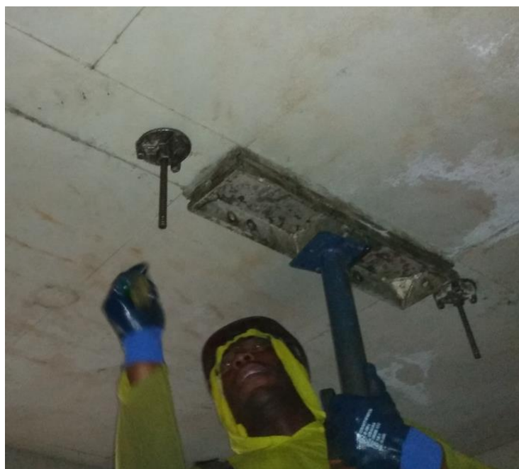
Figura 50: Montador fixando as agulhas
