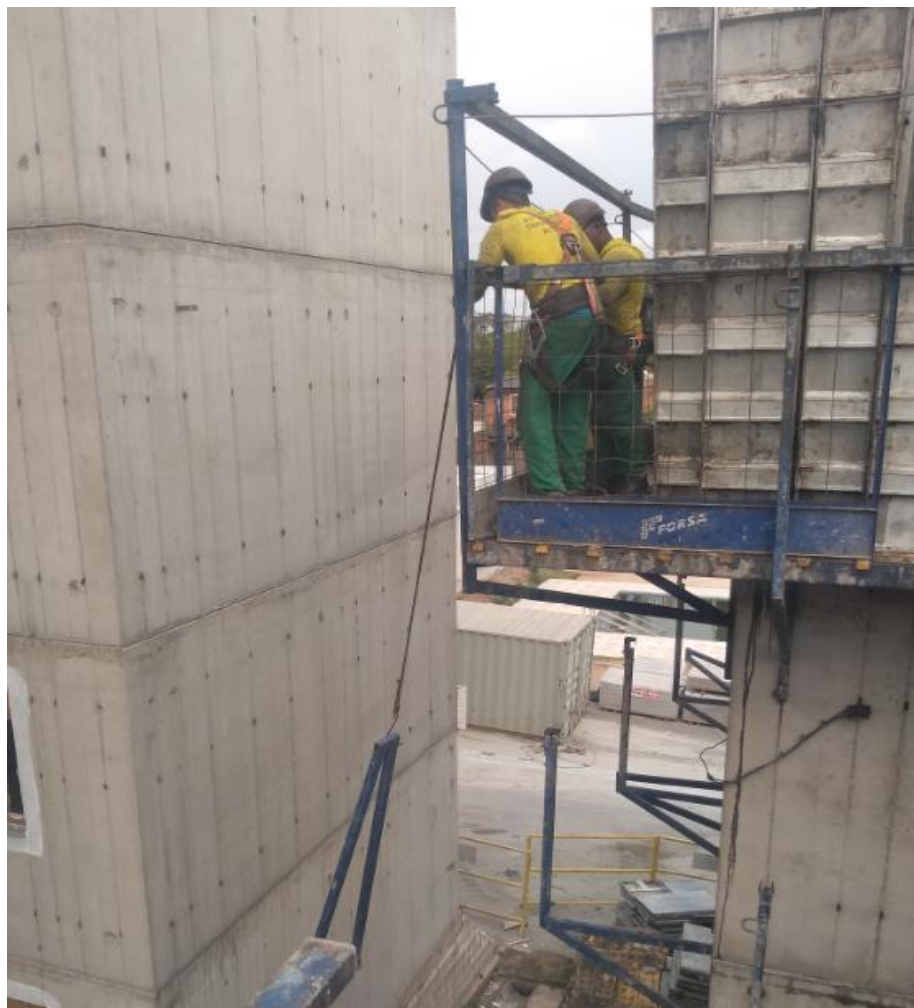
Figura 86: Montador elevando a mão-francesa
