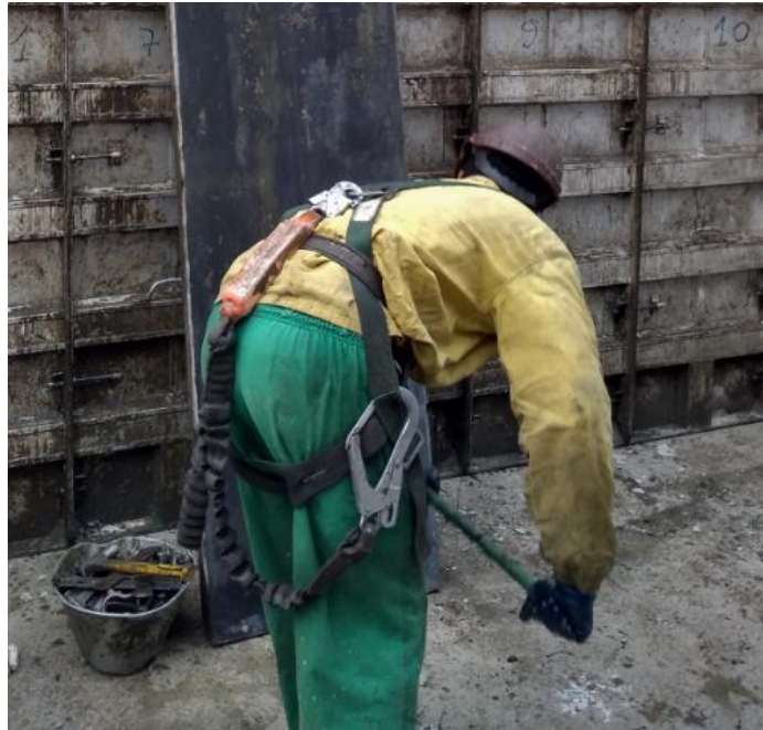
Figura 73: Montador aplicando desmoldante na placa
