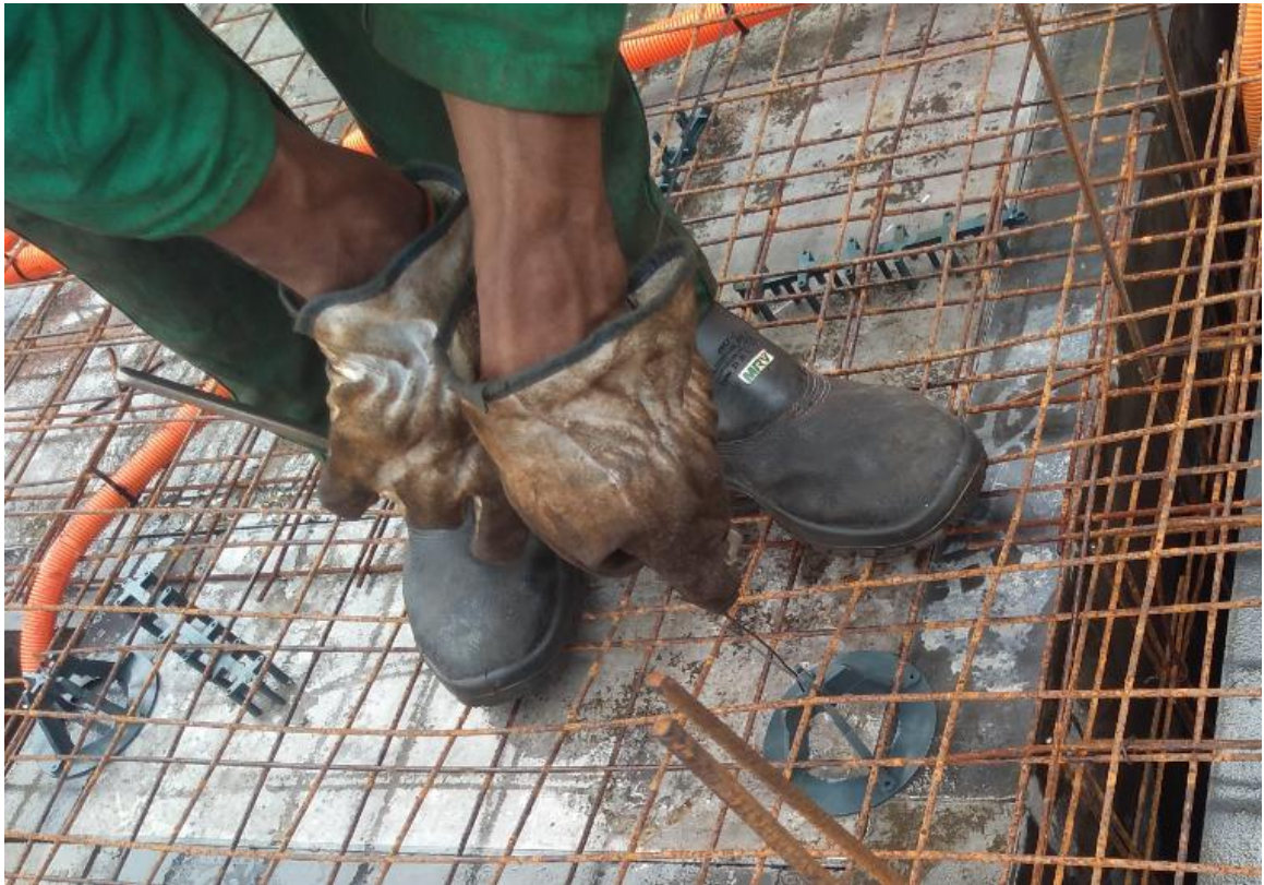
Figura 103: Fixação dos espaçadores chapéu de bruxa
