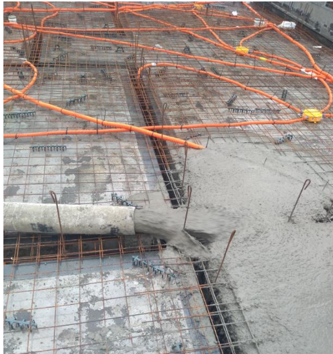
Figura 111: Lançamento do concreto
