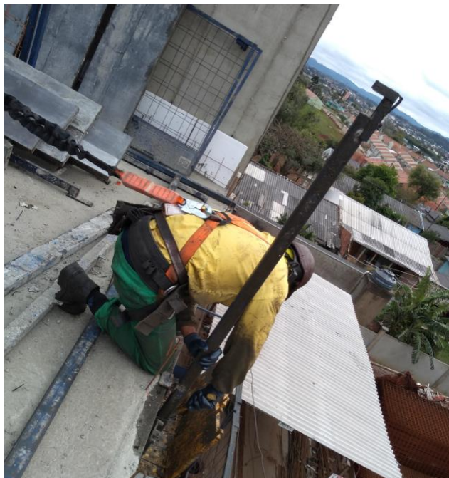
Figura 56: Montador clipado na linha de vida
