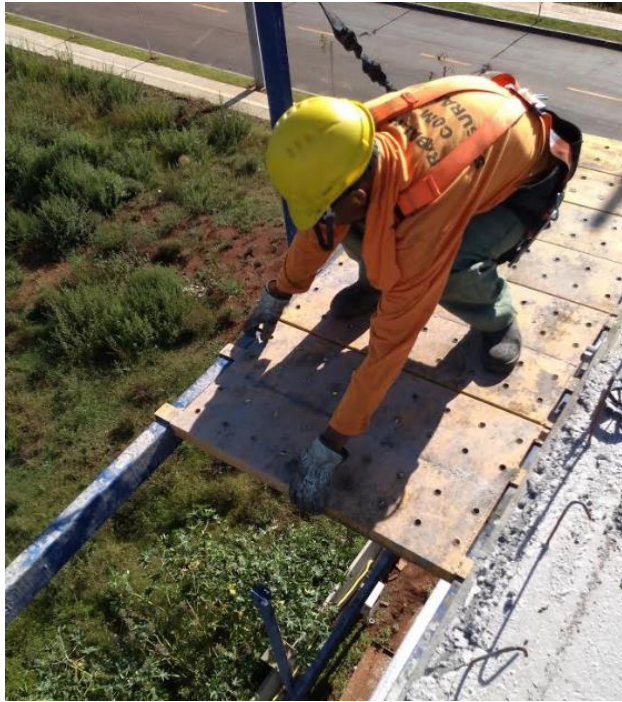
Figura 84: Montador montando o assoalho
