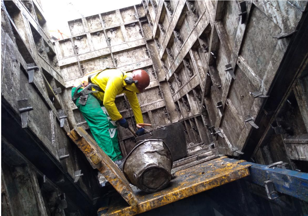
Figura 61: Montagem do envelopamento interno da escada
