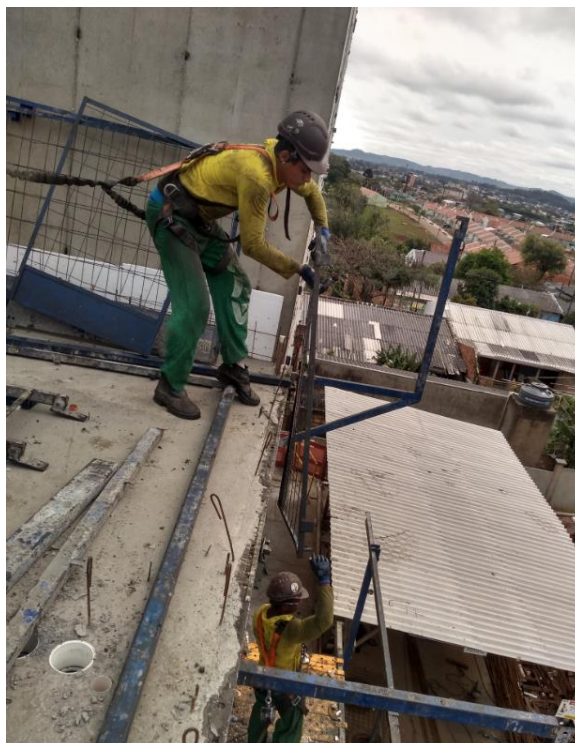
Figura 83: Montador elevando as peças de guarda-corpo
