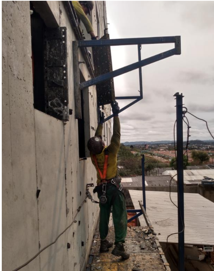
Figura 81: Montador elevando o assoalho
