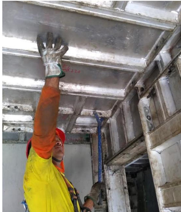
Figura 75: Montador desmontando painel de laje
