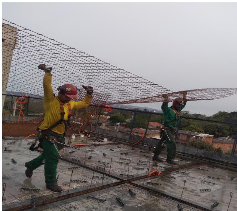
Figura 99: Armadores movimentando as telas
