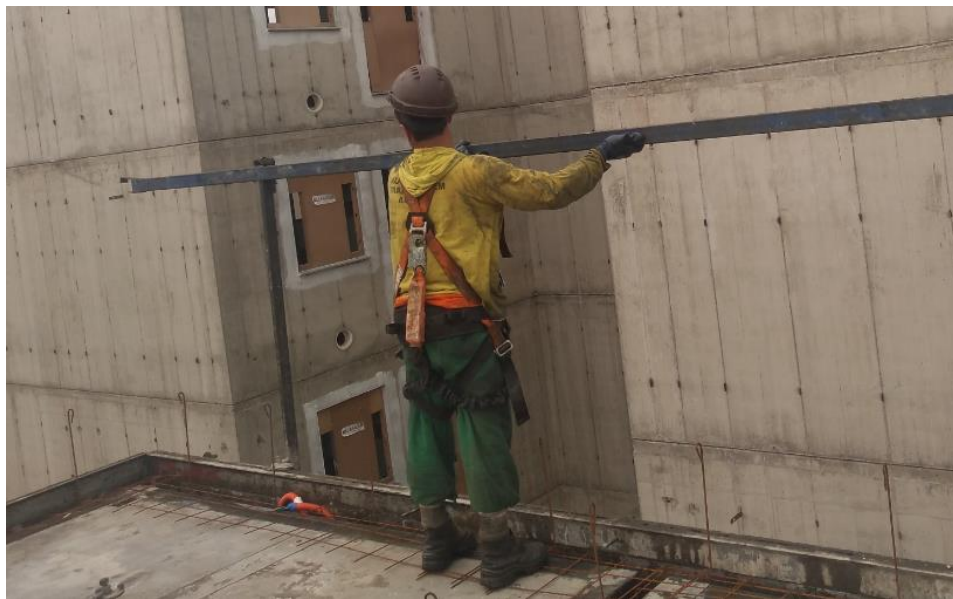
Figura 93: Montagem da longarina superior
