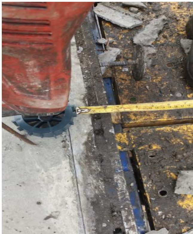
Figura 44: Marcação das paredes externas
