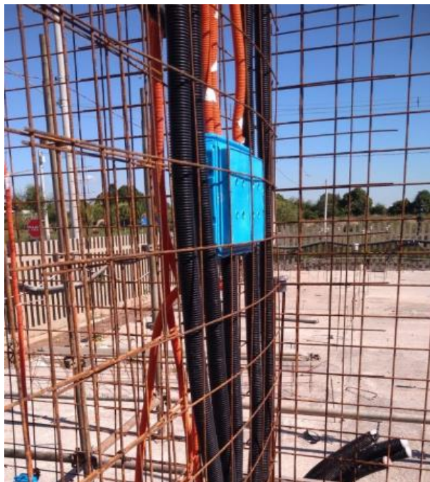
Figura 124: Reforço de malha dupla
