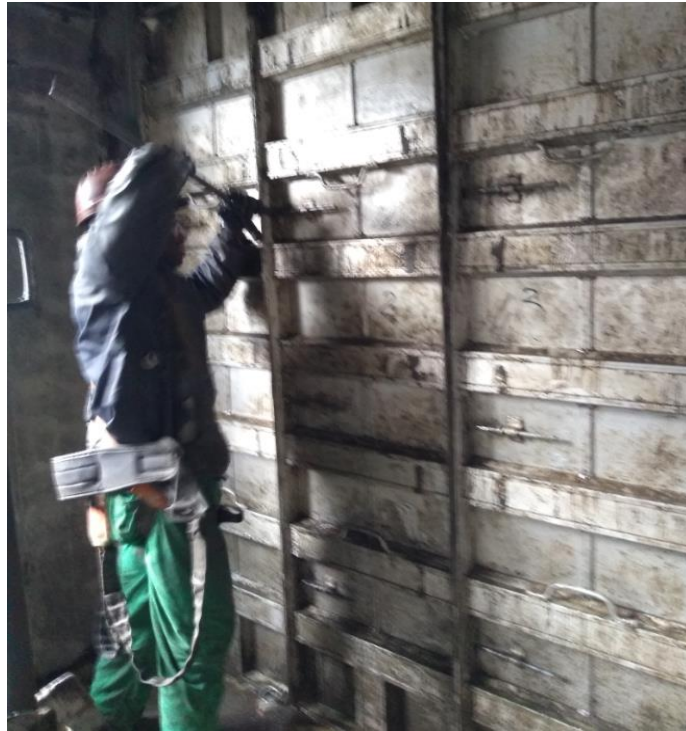
Figura 66: Montador desmontando o painel de parede
