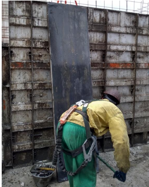
Figura 17: Aplicação do óleo desmoldante
