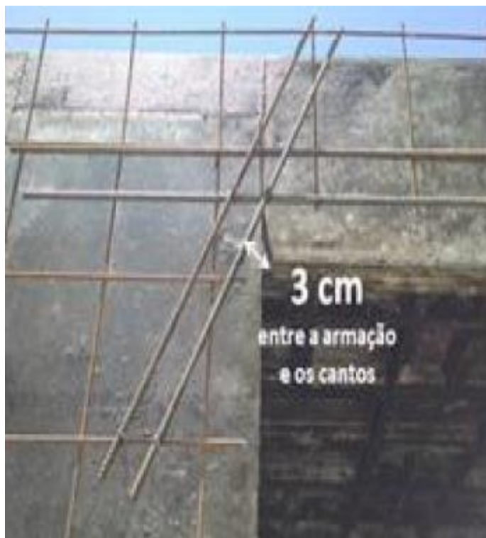
Figura 126: Cobrimento dos reforços
