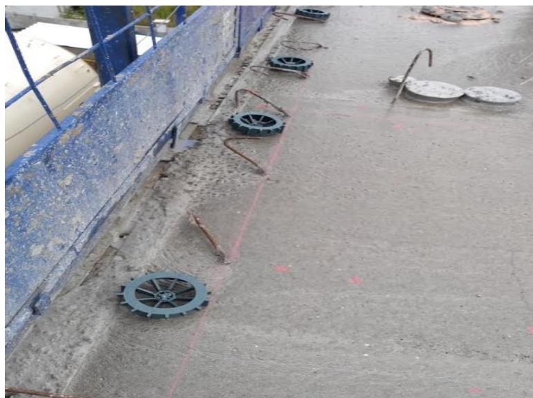
Figura 10: Linha de marcação na laje
