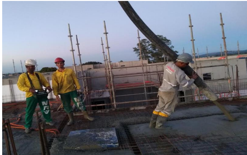
Figura 18: Lançamento do concreto
