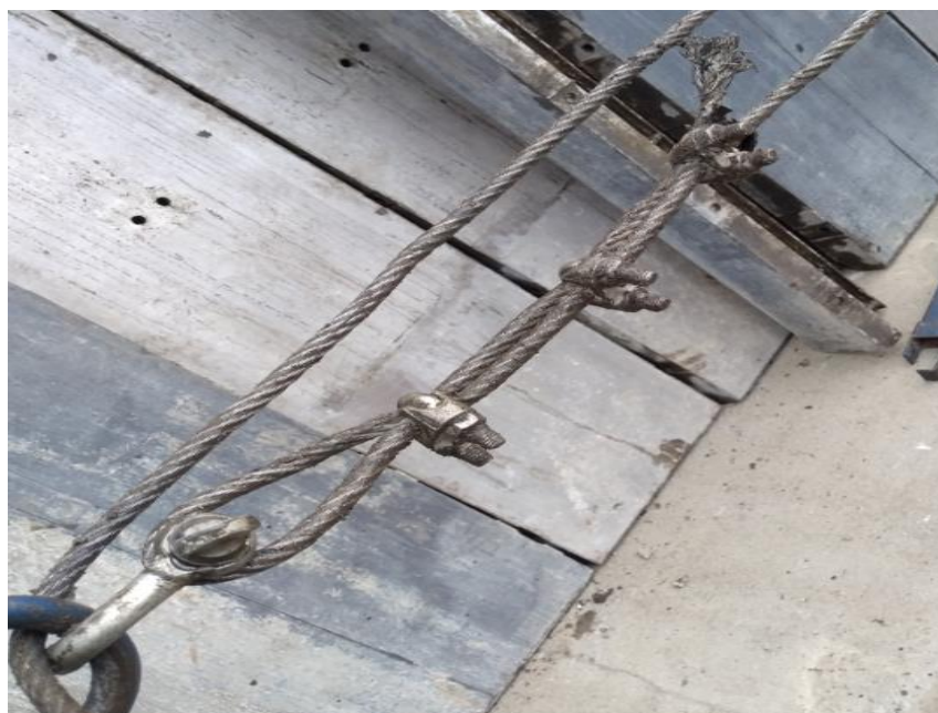
Figura 91: Cabo de linha de vida fixado com 3 cliques
