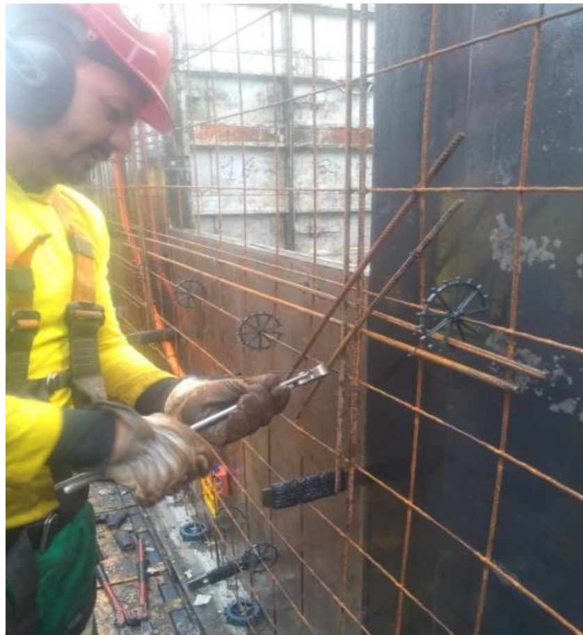
Figura 125: Fixação dos reforços de aberturas
