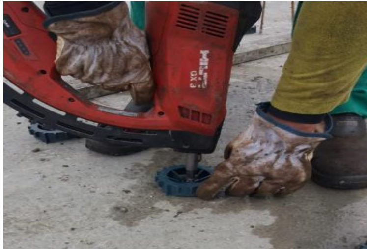
Figura 46: Fixação dos espaçadores
