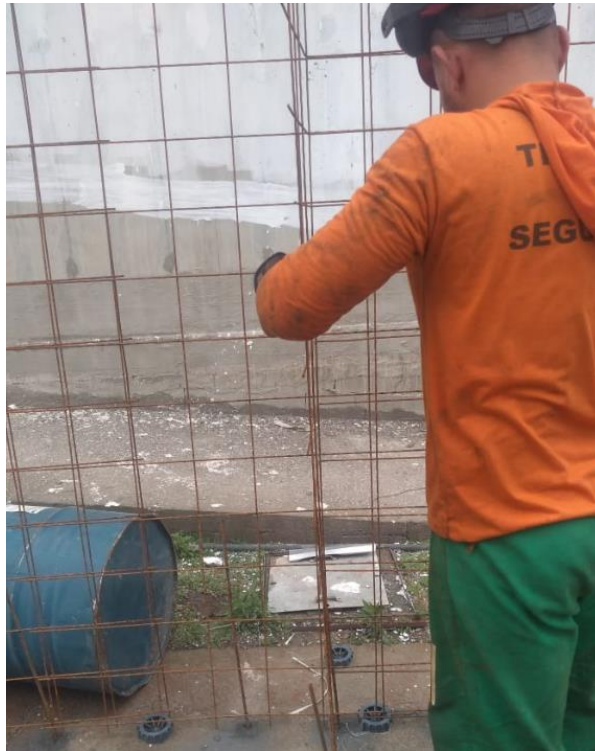
Figura 5: Instalação das telas de aço
