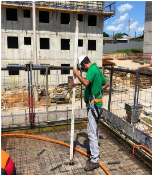
Figura 110: Conferência do nível da laje
