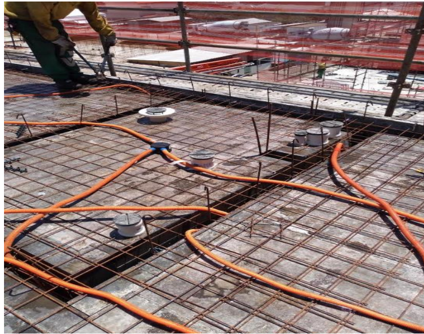
Figura 8: Instalações elétricas na laje
