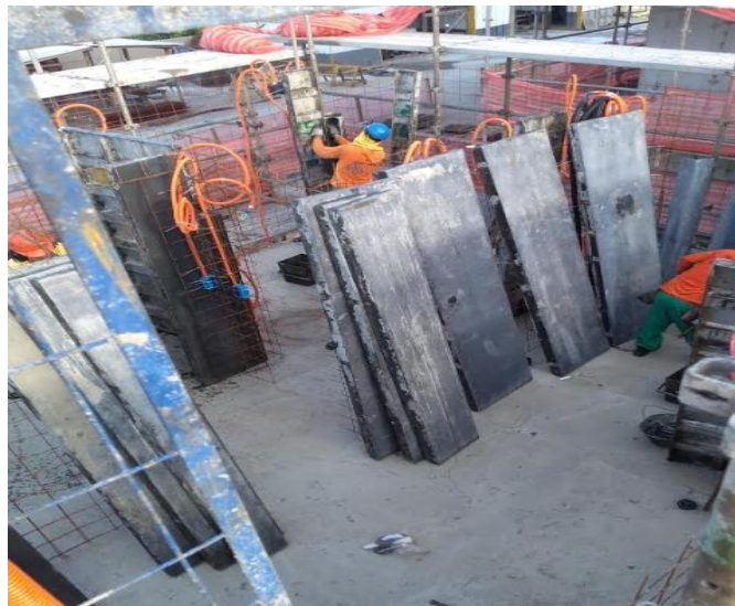
Figura 11: Montagem iniciando pelos painéis internos
