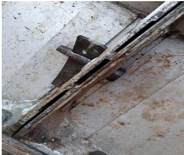
Figura 14: Pino e cunha para fixação dos painéis
