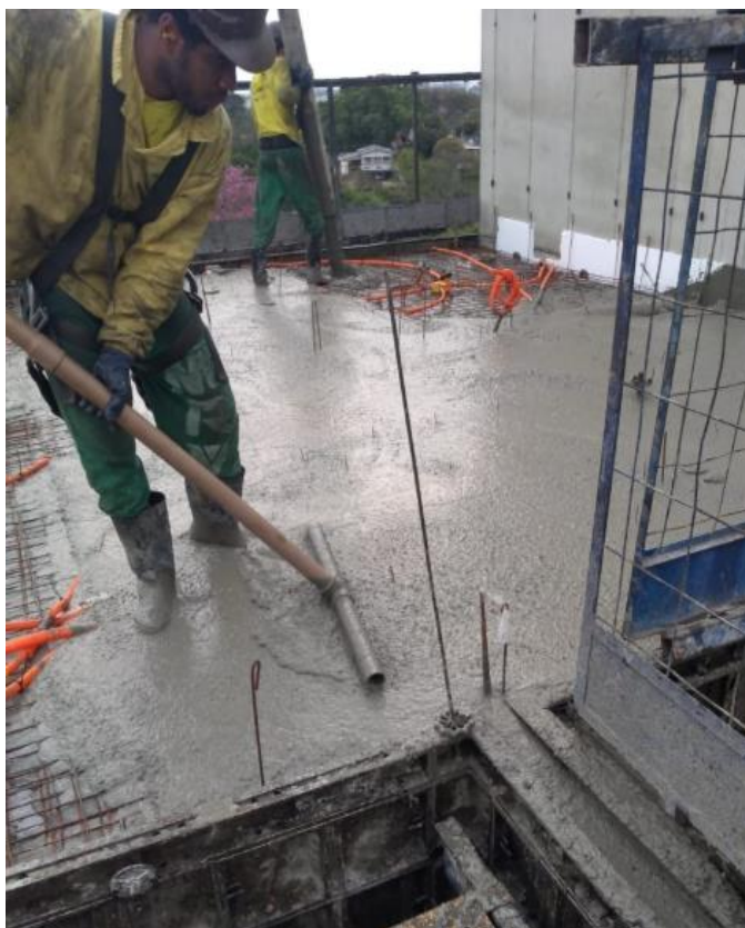
Figura 113: Montador realizando o nivelamento da laje
