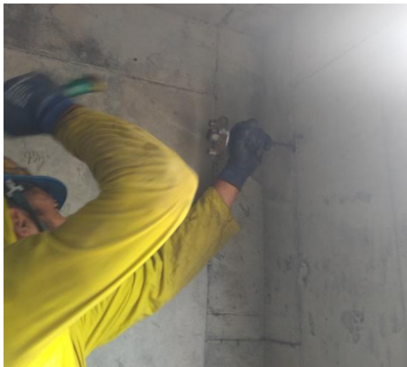
Figura 80: Montador fixando a agulha com a borboleta
