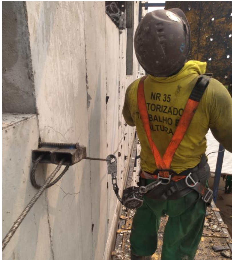
Figura 78: Montador fixado na linha de vida de muro
