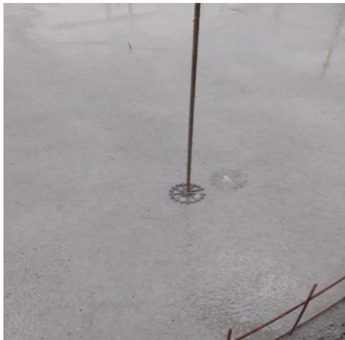
Figura 116: Medição do nível da laje
