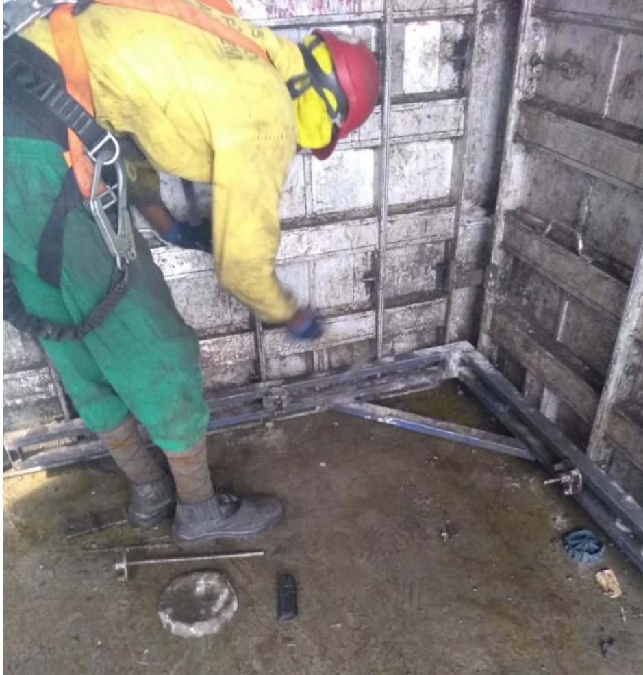
Figura 65: Montador retirando o esquadro
