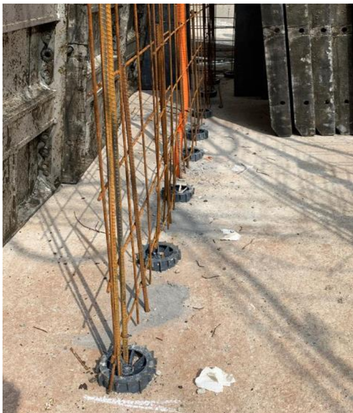
Figura 122: Telas fixadas nos arranques da laje
