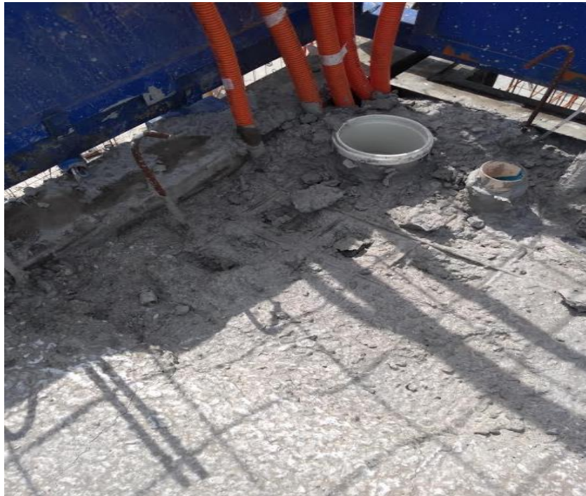
Figura 9: Instalações elétricas na laje
