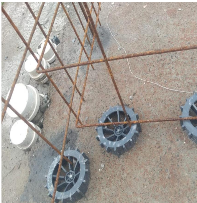
Figura 121: Cantoneiras centralizadas no eixo da parede
