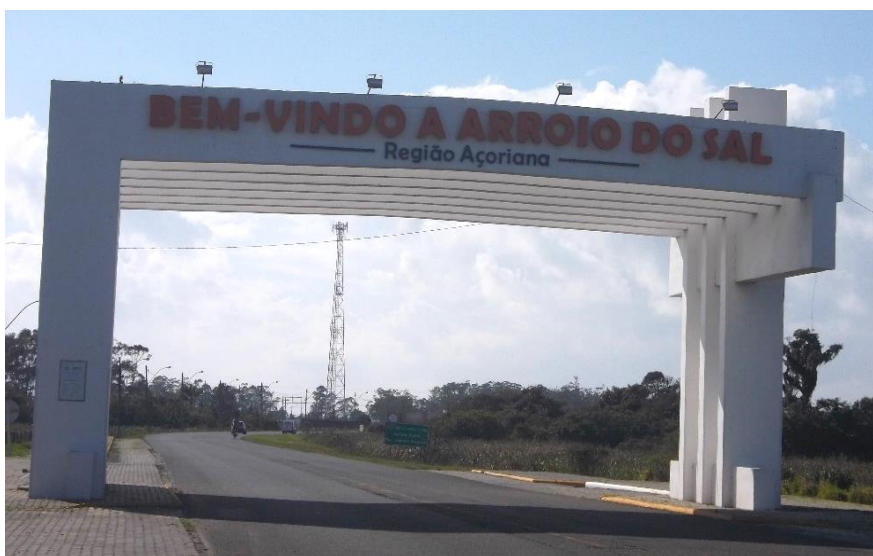
Figura 7 – Pórtico de entrada do Município de Arroio do Sal
