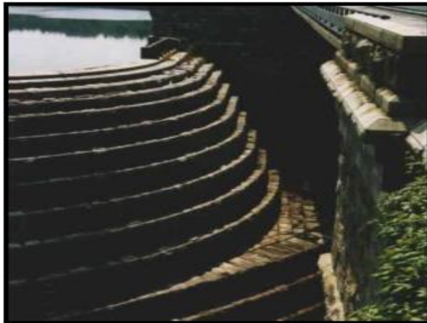
Figura 2 – Barragem de New Croton, Estados Unidos (1906).
