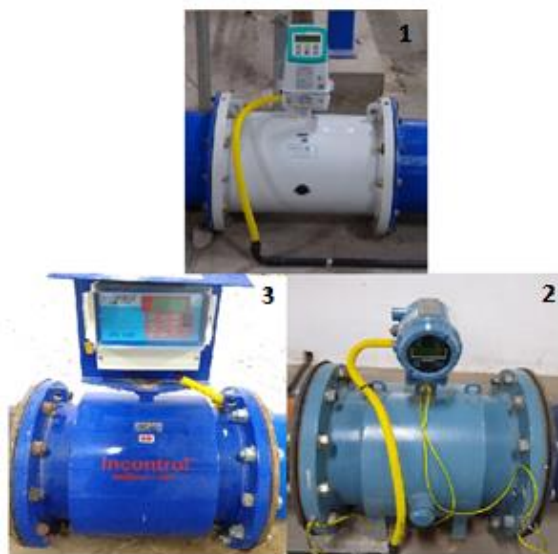
Figura 24 – Medidores de vazão
