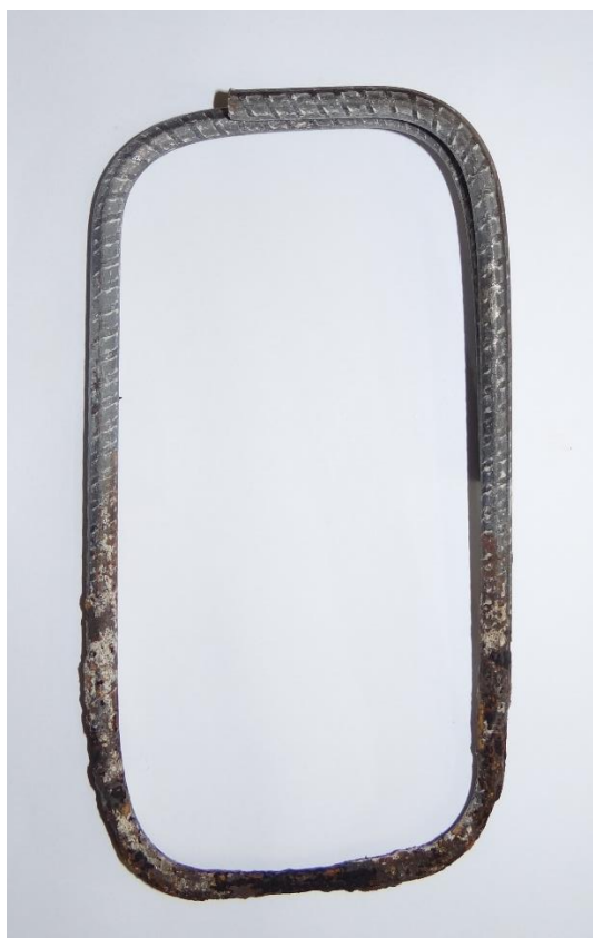
Figura 31 - Estribo retirado da viga V06CO.
