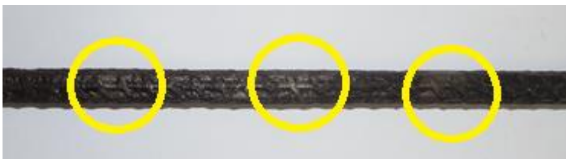
Figura 30 - Zona da barra longitudinal protegida pelo estribo.
