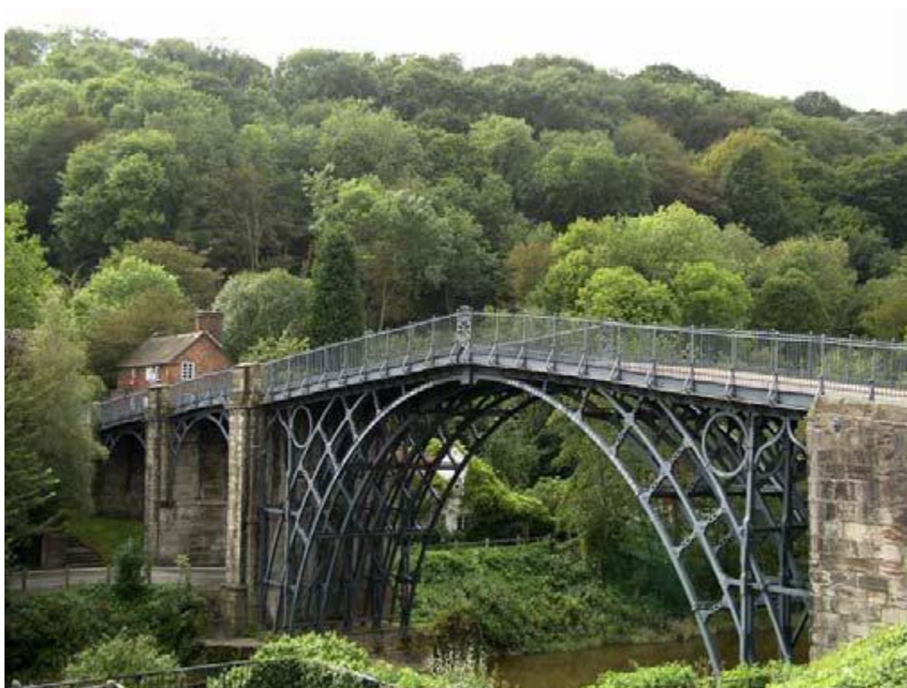
Figura 1 - Ponte de Coalbrookdale, Inglaterra.
