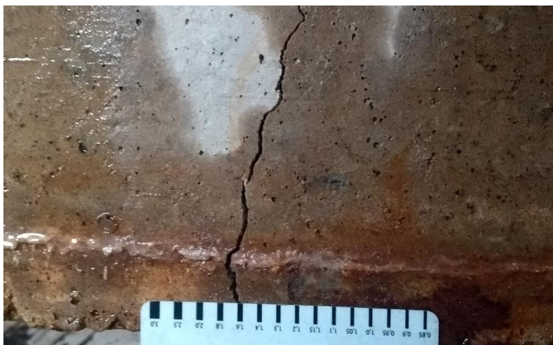
Figura 58 - Medição da abertura de fissura da viga V09COFA.
