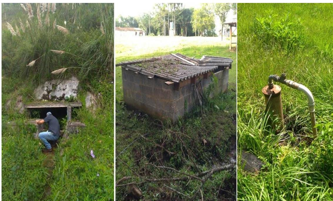
Figura 12 - Diferentes fontes de captação encontrados em etapa de campo: fonte de encosta, poço escavado e poço tubular. Fonte: Autora.
