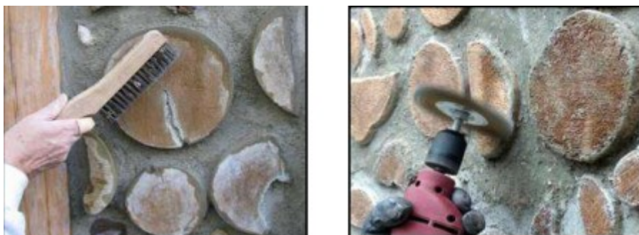
Figura 38: Uma escova de aço ou uma furadeira adaptada podem realizar o acabamento (FLATAU, 2017, p.95)
