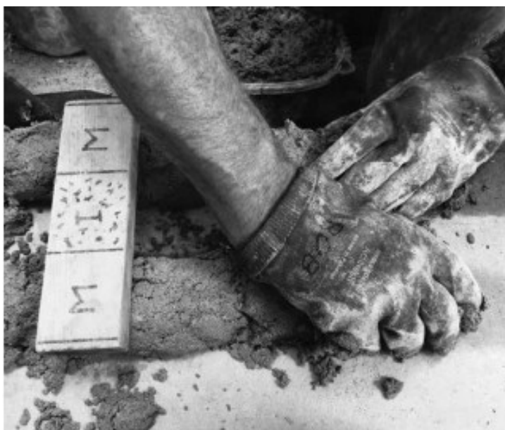
Figura 30: Com cada mão desenvolvendo uma linha se acelera o processo (ROY, 2018, p.60).
