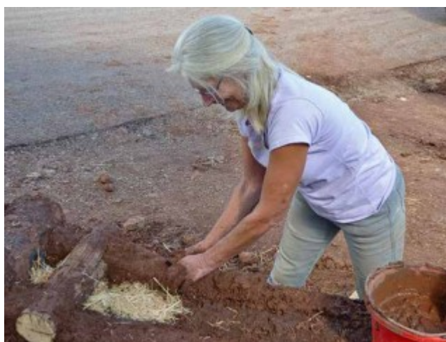
Figura 21: Palha sendo usada entre as linhas de cob fornece isolamento térmico e economizando trabalho (ROY, 2016, p.122).
