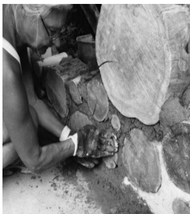
Figura 36: Ao raspar a argamassa com uma mão se recolhe com a outra e o excesso pode ser imediatamente reutilizado (ROY, 2018, p.67)
