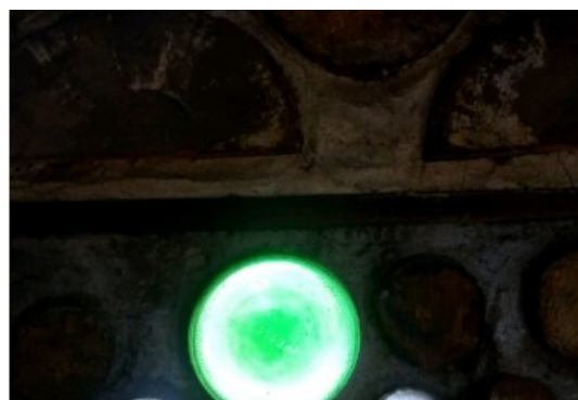
Figura 57: Diferença de cor entre a argamassa com areia grossa (em baixo) e média (em cima). (Foto de arquivo pessoal)
