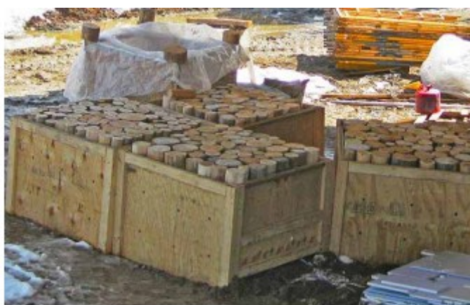
Figura 19: Tocos são levados à obra com equilíbrio na quantidade de cada diâmetro (ROY, 2016, p.155)
