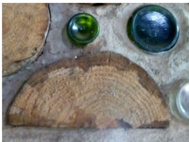
Figura 61: Madeira manchada por receber chuva após o corte. (Foto de arquivo pessoal)
