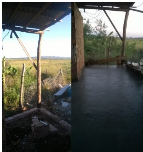
Figura 52: Execução do alicerce e do contrapiso. À esquerda, na foto da direita, pode-se observar o banheiro preexistente. (Foto de arquivo pessoal)
