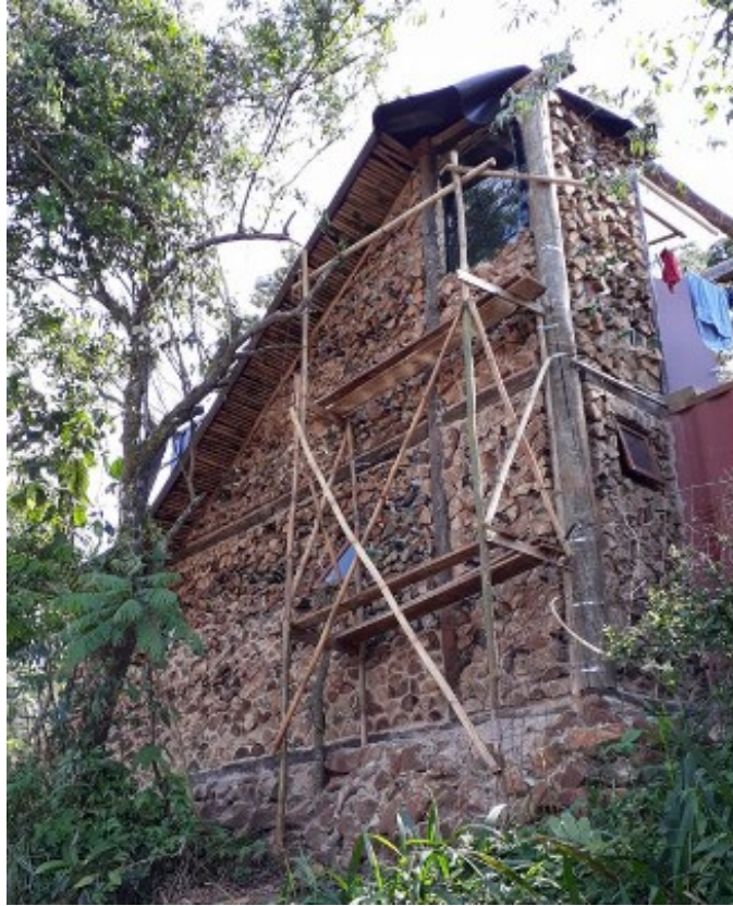
Figura 41: Fachada sul da edificação. Pode-se observar o andaime de taquara, usado apenas para apoiar materiais. (Foto de arquivo pessoal)
