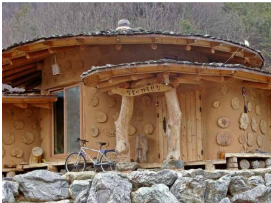
Figura 22: Uma típica casa de solo coreana. Não há camada de isolamento térmico (ROY, 2016, p.121)
