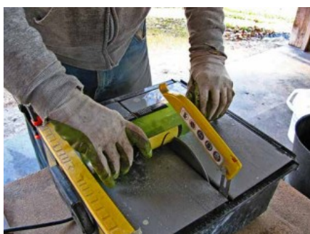
Figura 26: Em paredes com menos de 40cm de espessura, as garrafas são cortadas (ROY, 2016, p.77)
