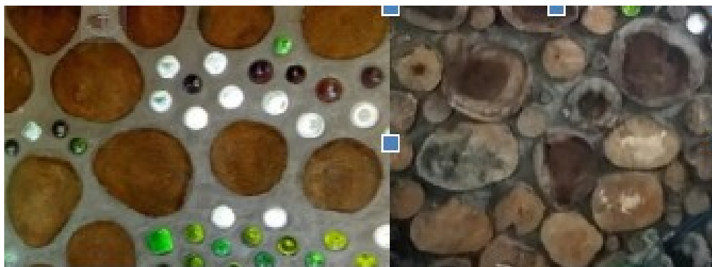
Figura 59: À esquerda juntas espessas, à direita juntas estreitas. (Foto de arquivo pessoal)
