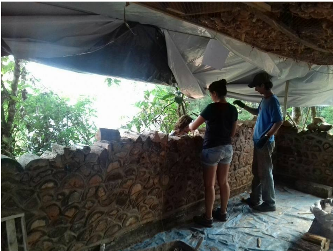
Figura 47: Rubin executando o canto, a alvenaria sendo erguida à medida que o canto subia e um voluntário apontando a argamassa no exterior. (Foto de arquivo pessoal)
