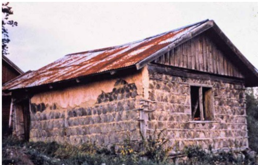
Figura 2: Uma antiga casa em Botkyra, Suécia, datada de 1860 (ROY, 2016, p.20). Se observa a construção em prateleiras. A argamassa é uma mistura de argila com 40% de serragem.
