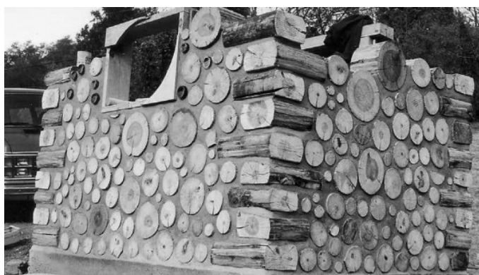
Figura 12: Tocos em fila única. Diferentes comprimentos dos tocos ajudam a evitar rachaduras por cisalhamento vertical na argamassa (ROY, 2018, p.43)
