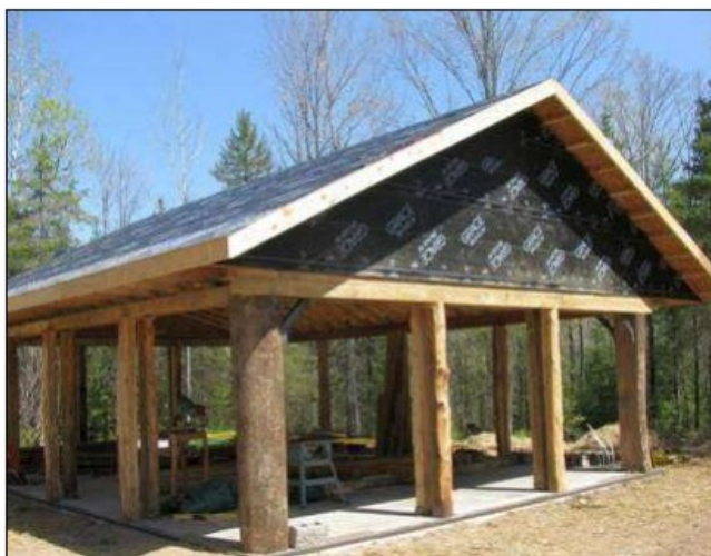
Figura 5: Estes pilares estão ancorados por chumbadores na laje de concreto (FLATAU, 2017, p.49)
