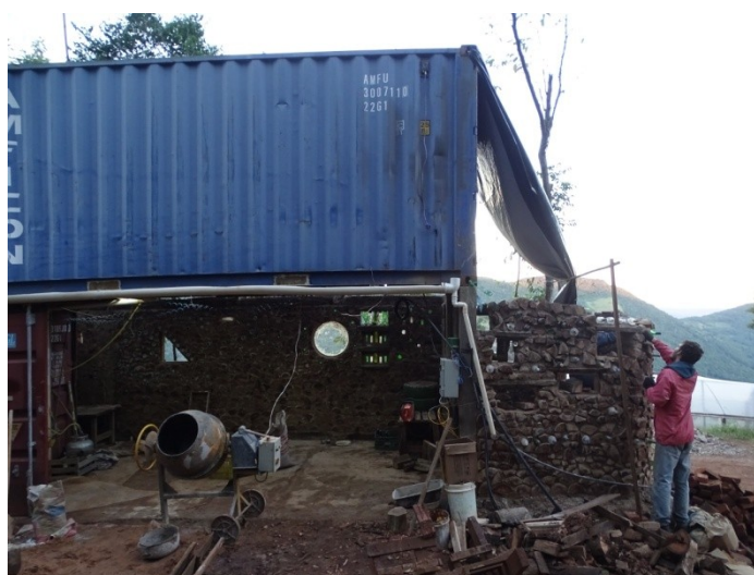
Figura 44: A betoneira utilizada e, à direita, um voluntário apontando a argamassa exterior (Foto de arquivo pessoal)
