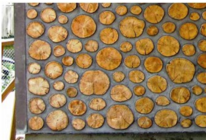
Figura 20: O equilíbrio se reflete na parede. Observa-se constância nas distâncias mínimas entre os tocos. (ROY, 2016, p. 161)
