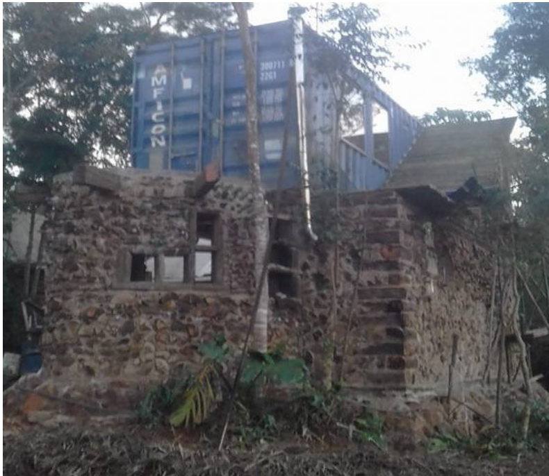
Figura 42: Fachada oeste. Observa-se o canto com tocos intertravados e a porção curva. (Foto de arquivo pessoal)
