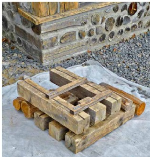
Figura 9: Esquina feita em fila dupla. Os frisos e as peças de amarração aumentam a fricção com a argamassa, não mostrada aqui. A cavidade interna é preenchida com material isolante térmico (ROY, 2016, p.14).
