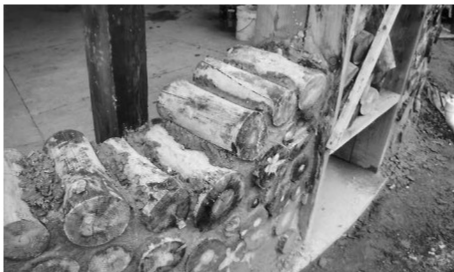
Figura 25: Tocos de Pinus assentados com argamassa de resíduo de papel e cimento (ROY, 2016, p.126 )
