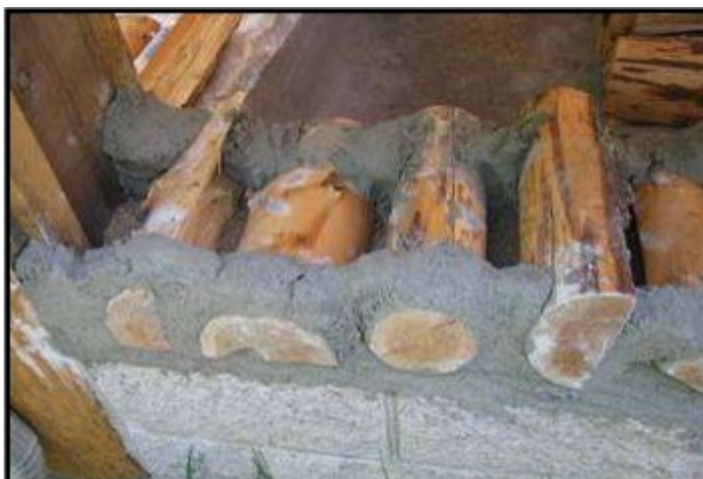
Figura 24: A argamassa apresenta uma consistência firme (FLATAU, 2017, p. 88).
