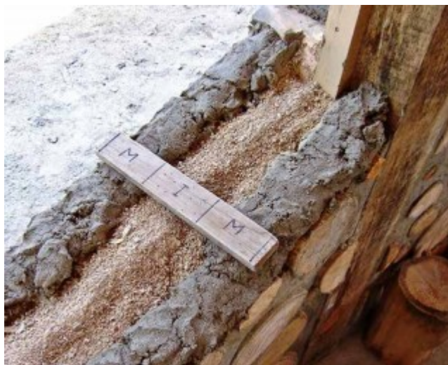
Figura 4: Isolamento térmico (serragem no caso) entre as linhas de argamassa (ROY, 2016, p. 40)
