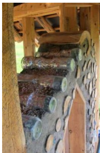
Figura 29: fundos de garrafas envoltas em papel alumínio assentados na parede (FLATAU, 2017, p.101)
