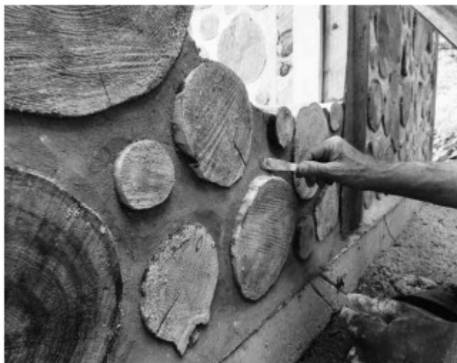
Figura 37: Uma faca com a ponta dobrada esta sendo usada para apontar a argamassa (ROY, 2018, p.68)
