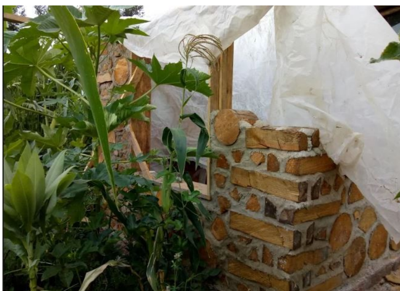
Figura 53: O canto foi executado com peças de 40 cm e 50 cm. (Foto de arquivo pessoal)
