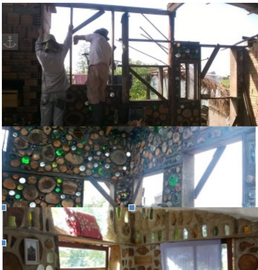
Figura 54: Pode-se observar que a seção superior dos marcos são contínuos ao longo da parede, fornecendo contraventamento. (Foto de arquivo pessoal)
