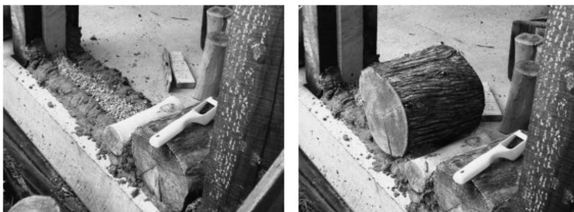
Figura 33: Tocos de diferentes diâmetros são posicionados sobre as linhas de argamassa e serragem (ROY, 2018, p.62)
