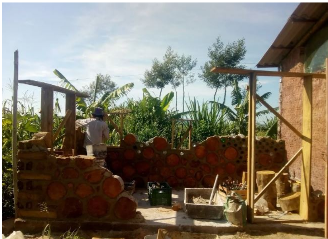
Figura 58: Ao centro pode-se observar caixa onde a argamassa foi misturada. (Foto de arquivo pessoal)
