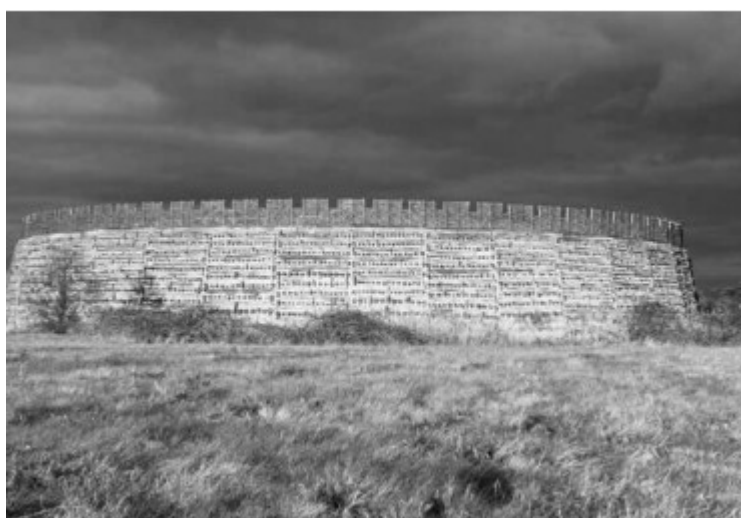
Figura 1: Forte Raddush, na Alemanha. As toras foram assentadas com terra, areia e argila (ROY, 2018, p.1)
