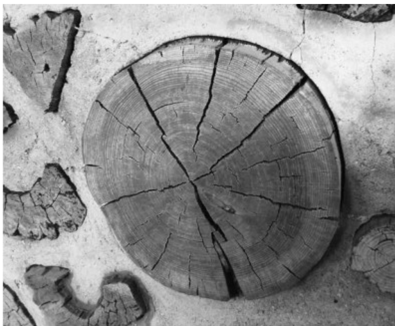
Figura 16: Um toco que apresenta rachaduras radiais e tangenciais com consequente afastamento da argamassa (ROY, 2018, p.18)
