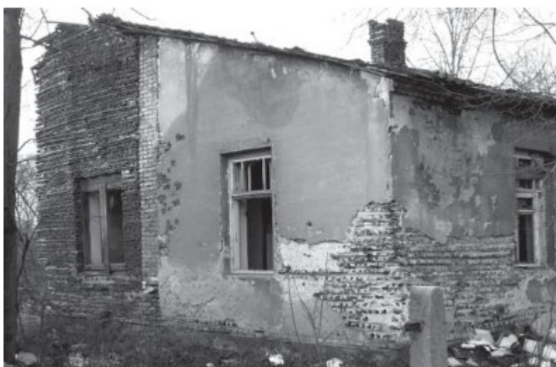
Figura 3: Uma casa construída na década de 1930 em Bialystok, Polônia (SZEWCZYK, 2007, p.6). A argamassa é à base de cal.
