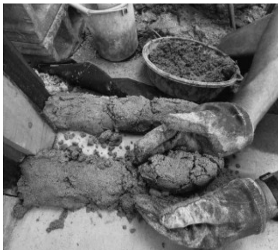
Figura 31: Para mãos menores ou argamassas mais espessas este método pode ser mais adequado. Note o balde de argamassa à mão (ROY, 2018, p.60).
