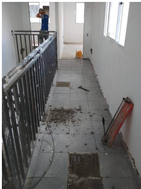
Figura 23 - Quebra de macro-fluxo entre cerâmica e fundo de massa. (Fonte: autora)
