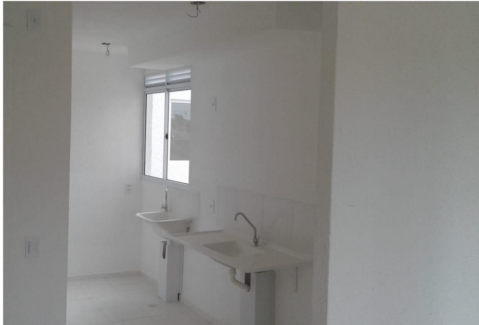
Figura 38 - Cozinha de um apartamento finalizado na torre 1. (Fonte: autora)
