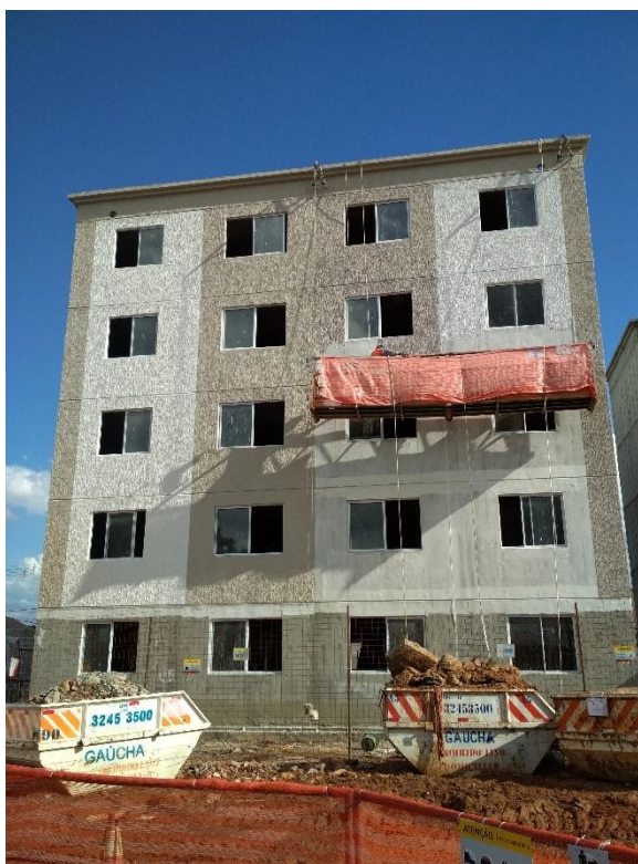
Figura 43 - Execução de textura na fachada da torre 1. (Fonte: autora)
