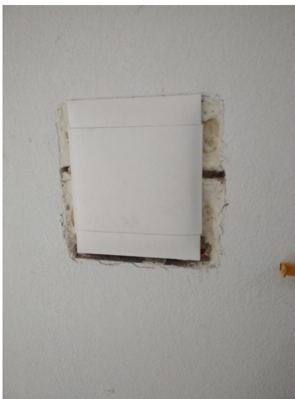
Figura 31 - Adaptação para colocação de acabamento elétrico no térreo. (Fonte: autora)
