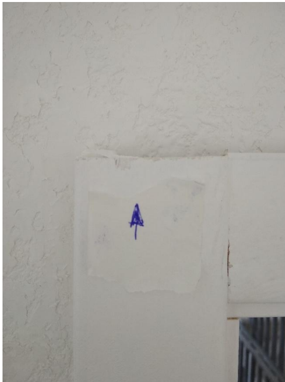
Figura 34 - Falta de qualidade pintura de portas. (Fonte: autora)
