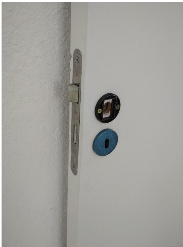
Figura 26 - Porta instalada sem acabamento. (Fonte: autora)
