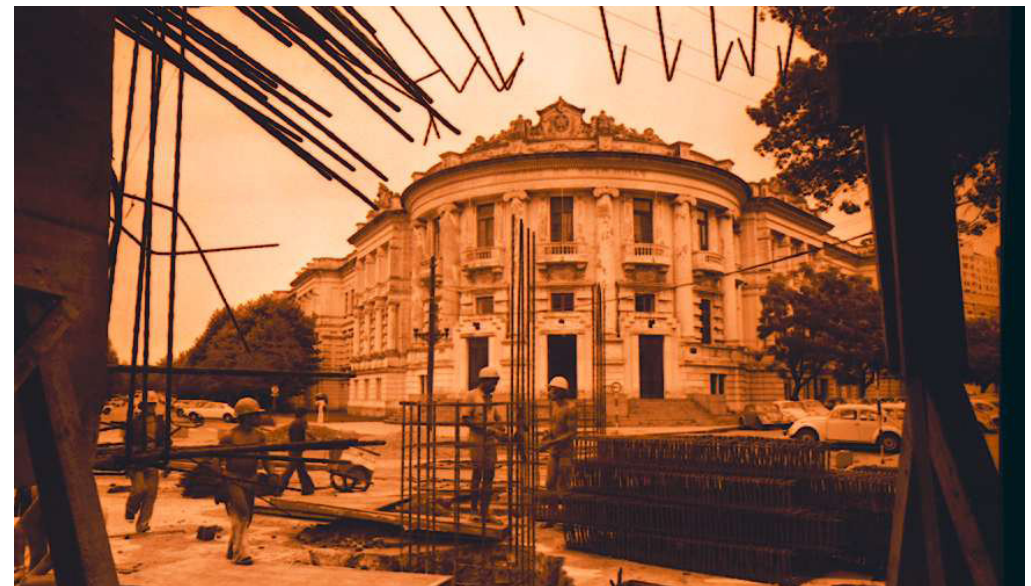
Construção do viaduto Imperatriz Leopoldina
