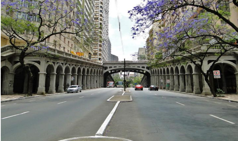
Figura 8: Viaduto Otávio Rocha
