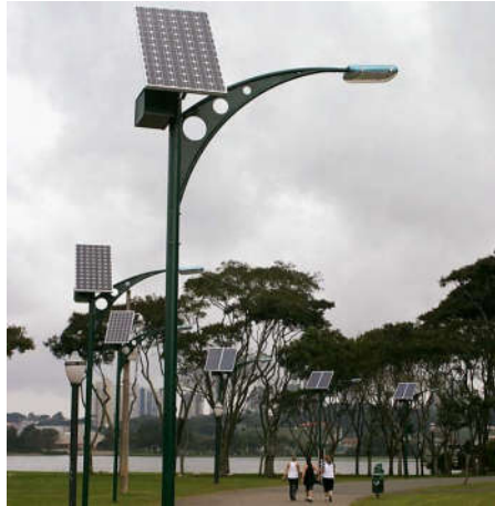
Figura 38 . Postes solares no Parque Barigui em Curitiba
