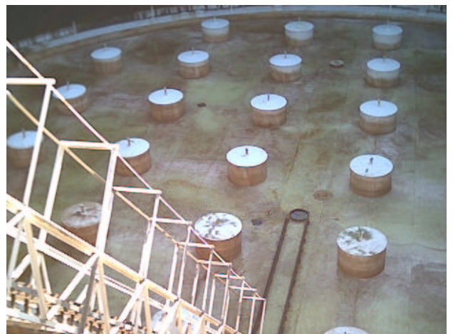
Figura 6: Escada de Acesso ao Teto
