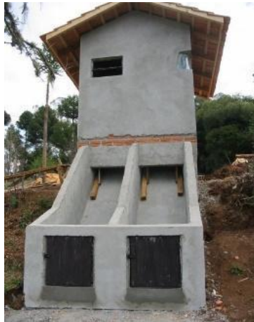
Figura 11 – Sistema de banheiro seco com duas câmaras
