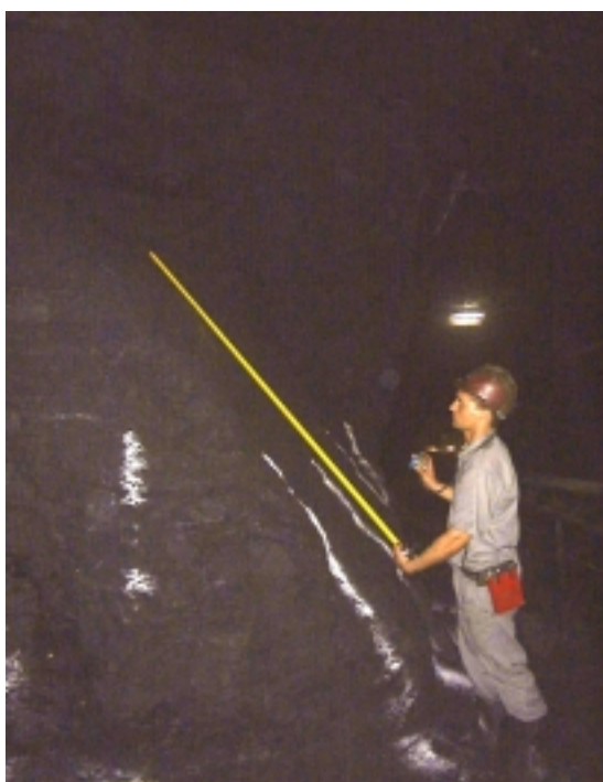
Figura 4.29 – Caimento de blocos devido a ocorrência de fraturamento oblíquo.
