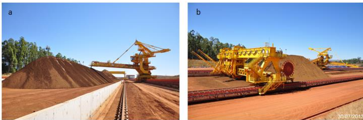
Figura 3-9: Pátio de Homogeneização mostrando (a) empilhamento de minério e (b) retomada
