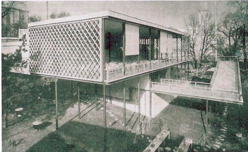
Fig. 157 — Pavillon japonais à l'Exposition de 1937. Sakakura, architecte.
