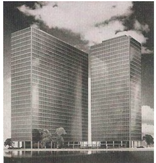
Fig 3 Proposta estrutural de Mies, pilares internos em rígida modulação que se reflete nas esquadrias fonte: Architectural Forum , novembro 1955 , pag 144
