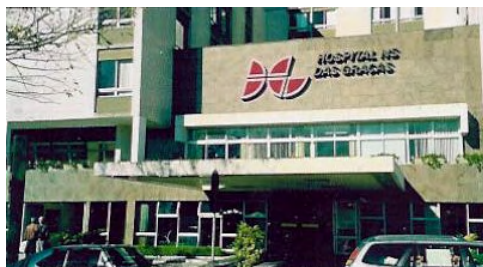
Fig 111 fachadas e acesso principal Hospital N Sra das Graças, 1969 foto autora 2001
