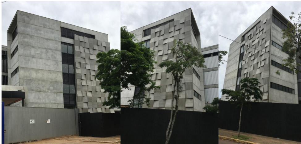
Figura 4: Painel em pré-moldado na fachada da edificação.
