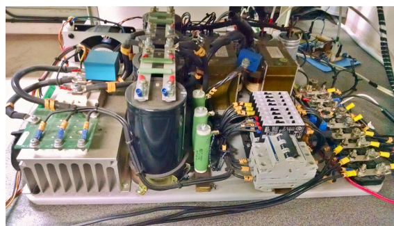
Figura 14: Circuito inversor utilizado na obtenção de resultados experimentais.
