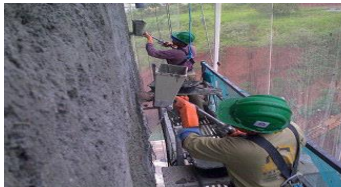
Figura 03 - execução de reboco externo com sistema de projeção
