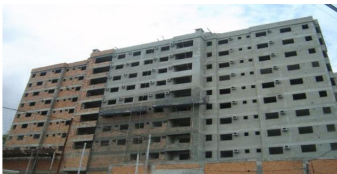
Figura 04 – Execução de reboco externo na fachada Leste
