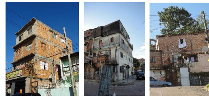
Padrão construtivo de favela da região OP Glória – Fonte: GPIT-UFRGS
