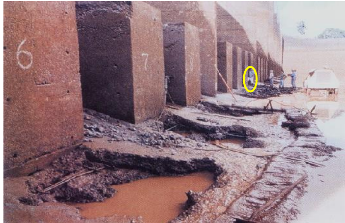
Figura 1: Danos observados na bacia de dissipação da UHE Porto Colômbia, em destaque indivíduo para referência de escala (Fonte: CBDB, 2010).
