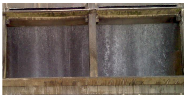
Figura 18 - Diferentes distribuições na vazão de água resfriada dentro de uma mesma célula
