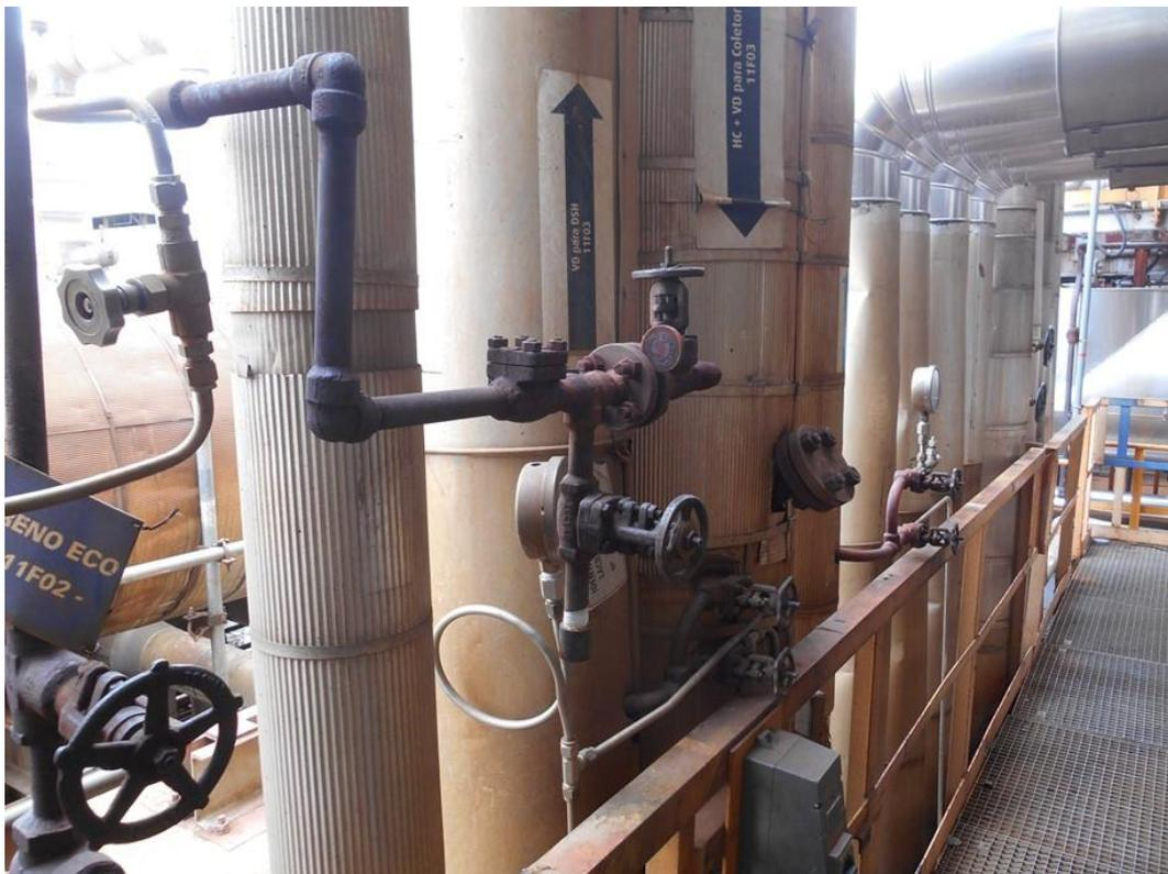
**Figura 17 - Indicador de pressão de tubulação anterior ao DSH, ponto de coleta do VD**
