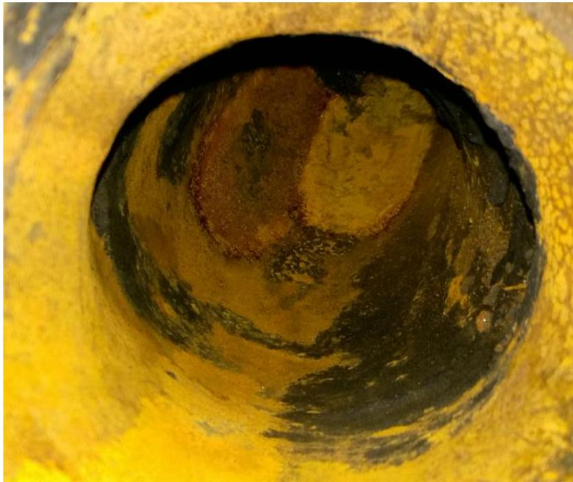
**Figura 25 - Trecho de tubulação de 6", curva após válvula de controle**
