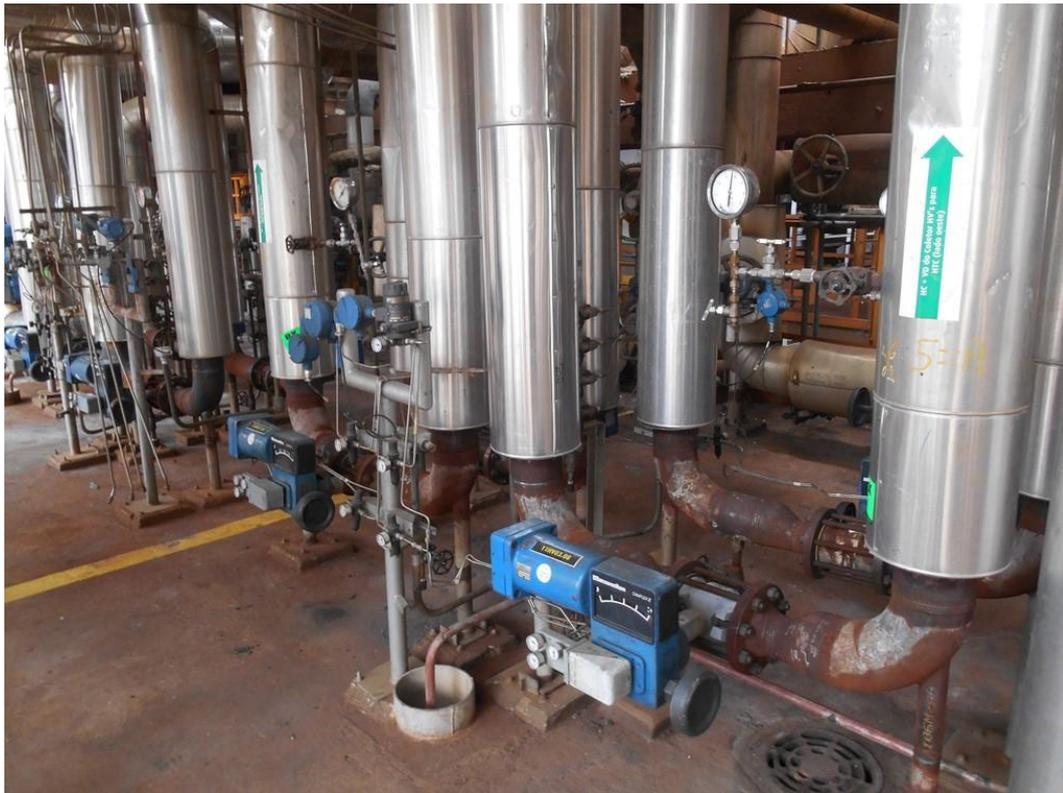
**Figura 16 - Indicador de pressão do sistema das HV's, ponto de coleta da mistura VD e HC**
