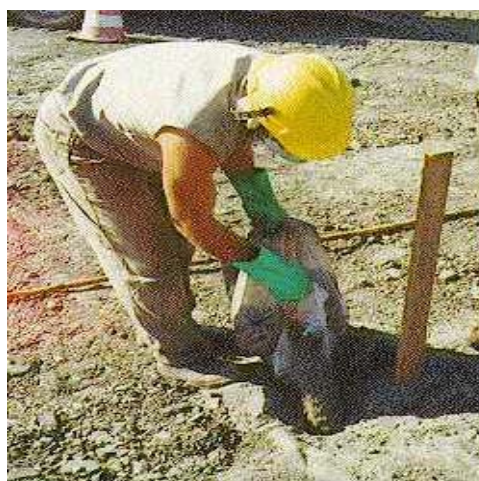
Figura 55. Carregamento a granel de furo com agente explosivo.
