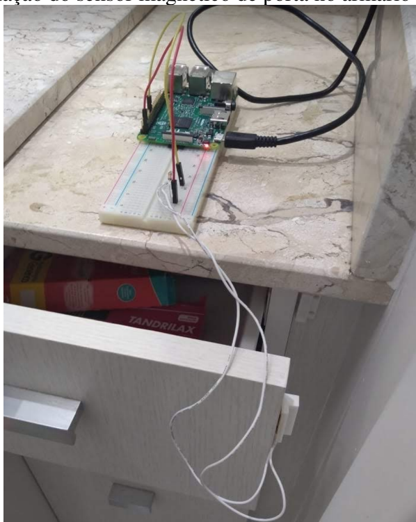
Figura 5.1: Instalação do sensor magnético de porta no armário de medicamentos.
