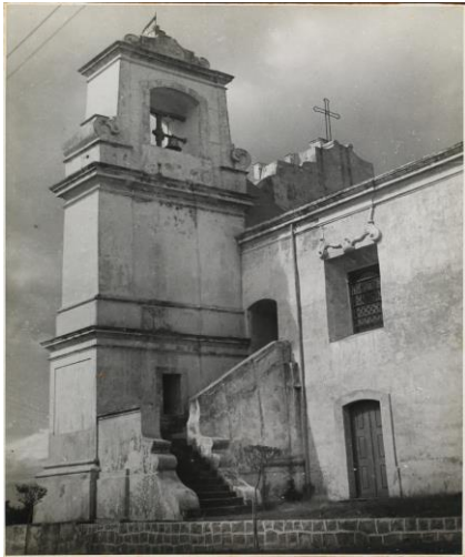
Fotografia 5 : lateral esquerda do prédio
