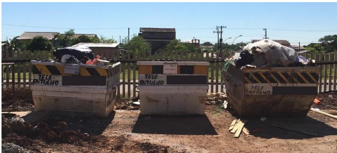
Figura 30 - Caçambas de entulho em condições precárias
