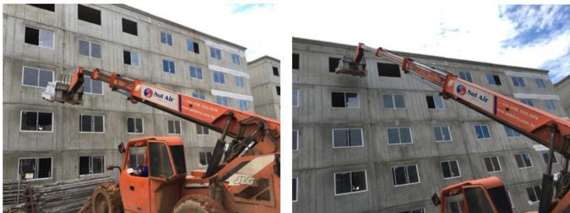
Figura 9 - Skytrak erguendo material em paletes diretamente para o local de utilização
