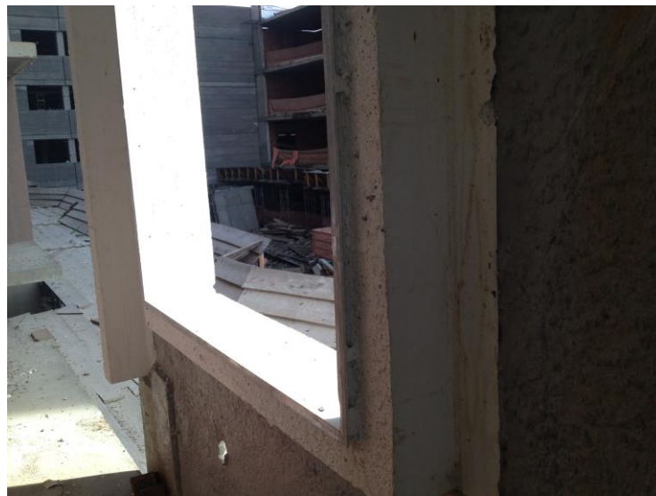
Figura 13 - Face interna de PPAC com contramarco colocado
