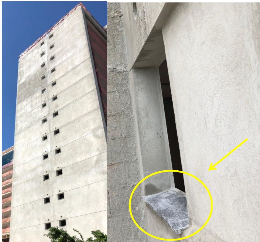
Figura 9 - Fachada revestida e detalhamento de peitoril já instalado
