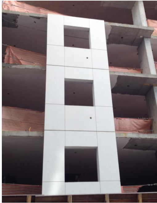
Figura 12 - Face externa de PPAC com acabamento desejado
