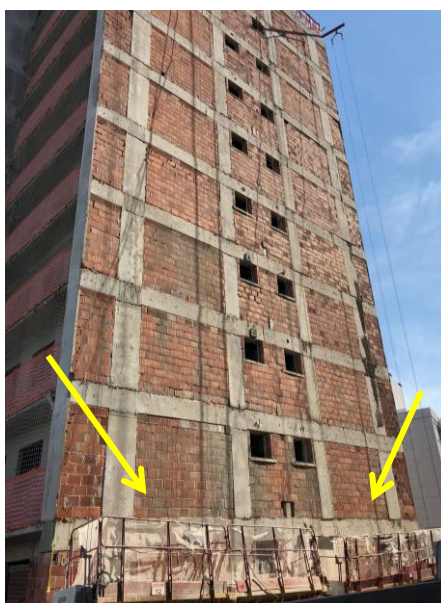
Figura 7 - Posicionamento de balancins para execução de revestimento após concluído levantamento da alvenaria
