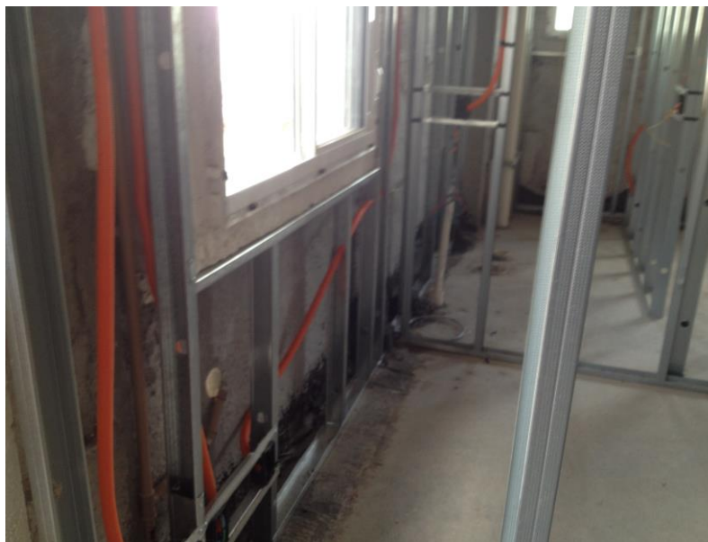
Figura 14 – Estrutura metálica para posterior revestimento interno de painéis com placas de gesso acartonado
