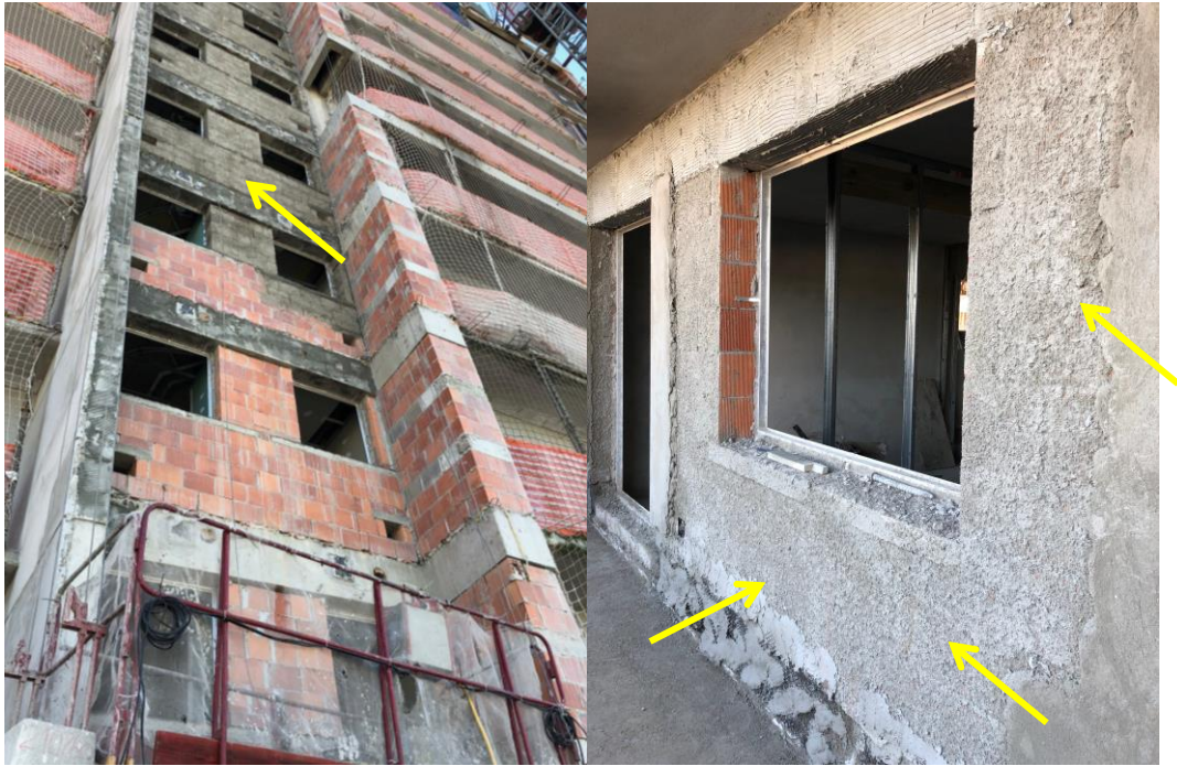
Figura 8 - Preparo da superfície da fachada para revestimento externo com andaime suspenso
