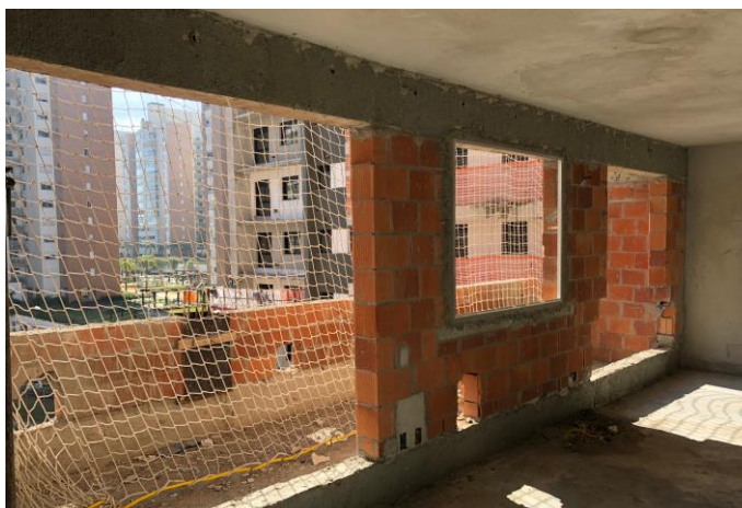
Figura 6 – Vista interna do levantamento de alvenaria e colocação de contramarcos em aberturas
