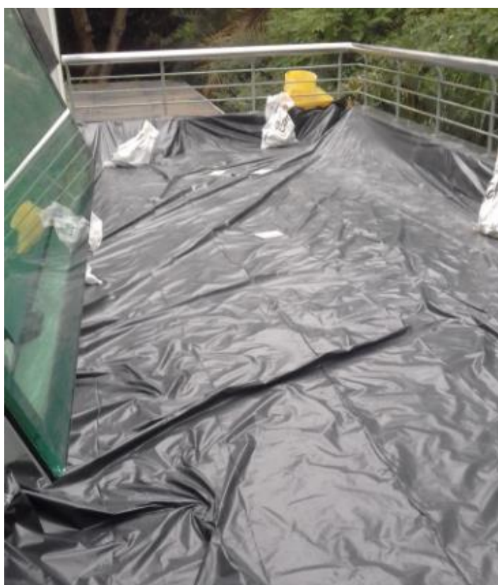
Figura 30 - Terraço 1 coberto com lona plástica após a remoção do contrapiso
