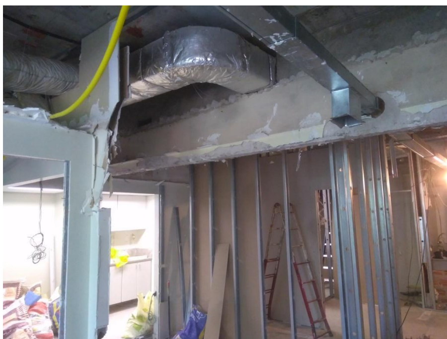
Figura 9 - Descoberta das vigas de concreto do andar superior durante a demolição
